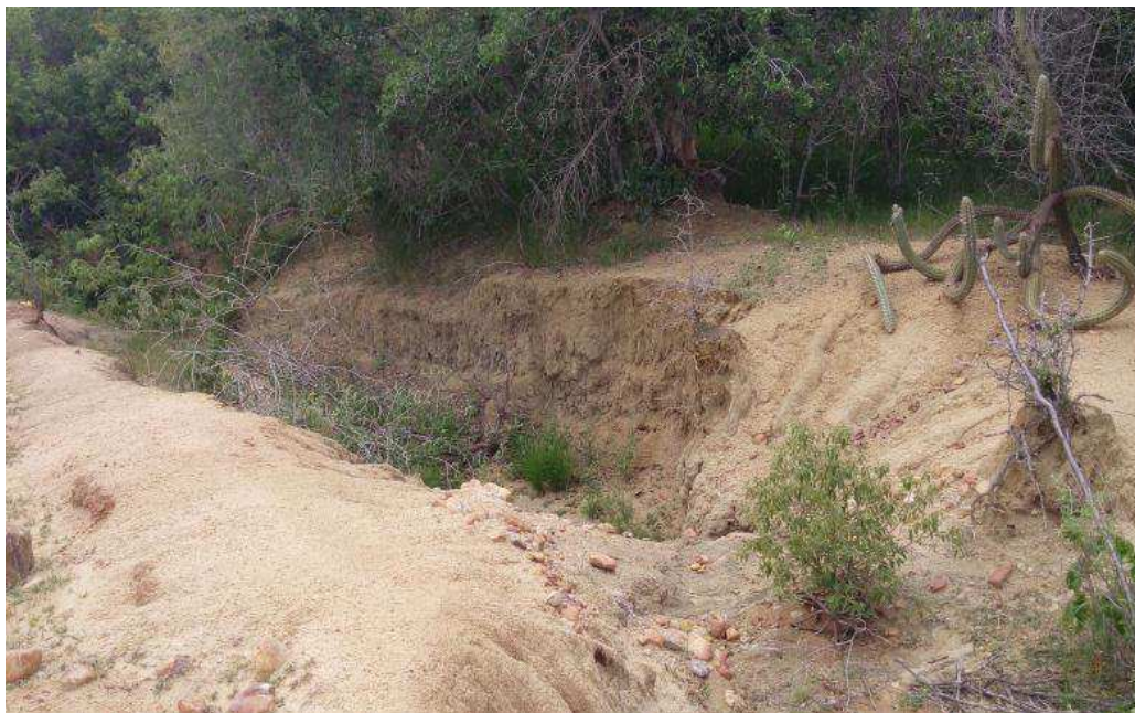
Figura 51. Processo de erosão do solo devido as chuvas intensas.
