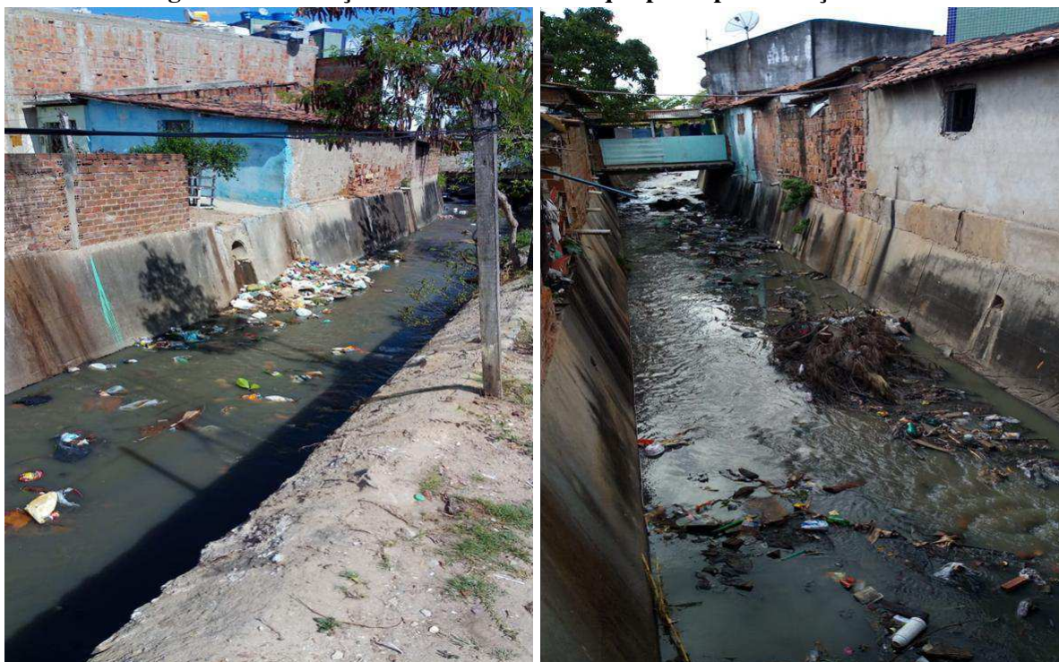
Figura 4.2 - Situação do trecho do canal que passa pela Estação Velha
