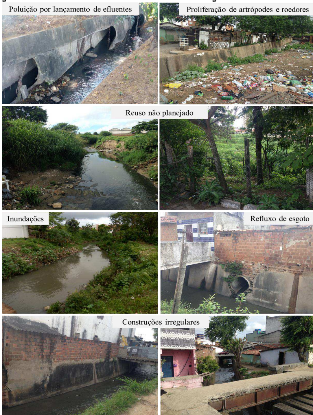
Figura 4.23 – Falhas encontradas no sistema de macrodrenagem da bacia urbana do Prado
