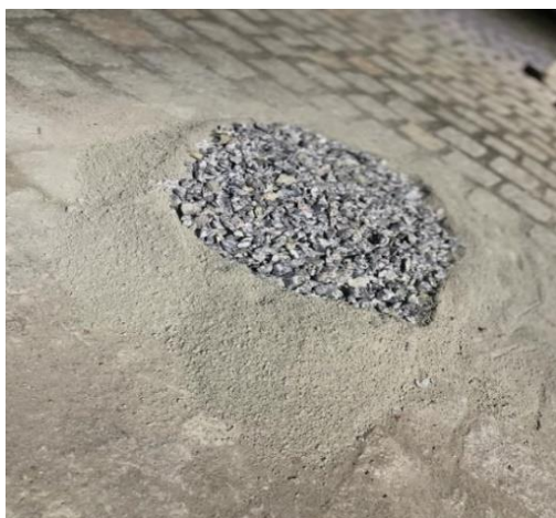
Figura 17 – Adição da brita na mistura. (Fonte: Autoria própria, 2023).
