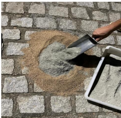
Figura 16 – Adição da areia e brita para iniciar o processo de mistura (Fonte: Autoria própria, 2023).
