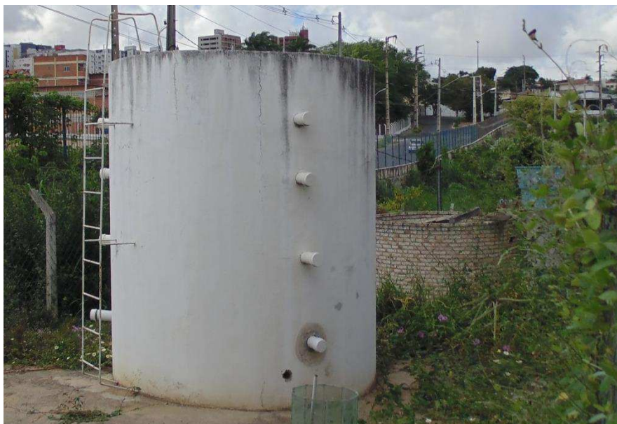
Figura 2. Biorreator construído em 2009.
