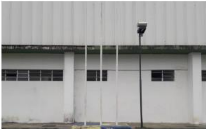
Figura 18 - Caracterização da estrutura | Fonte: Wilson Silva
