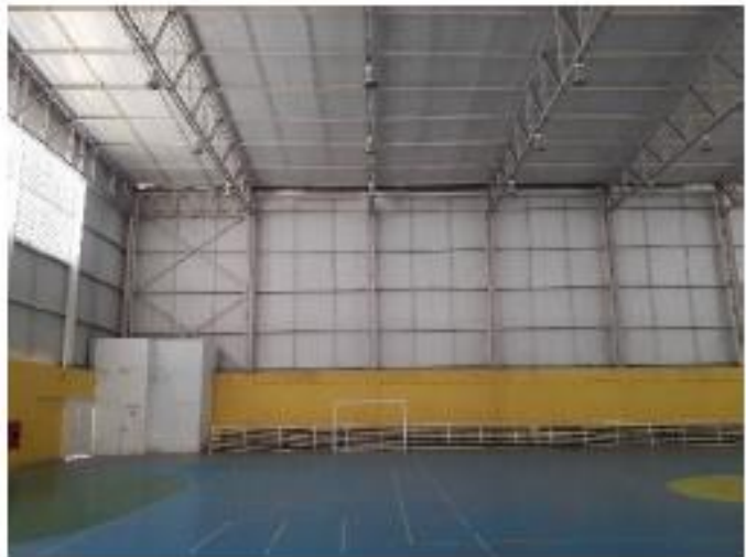
Figura 19 - Caracterização da estrutura | Fonte: Wilson Silva
