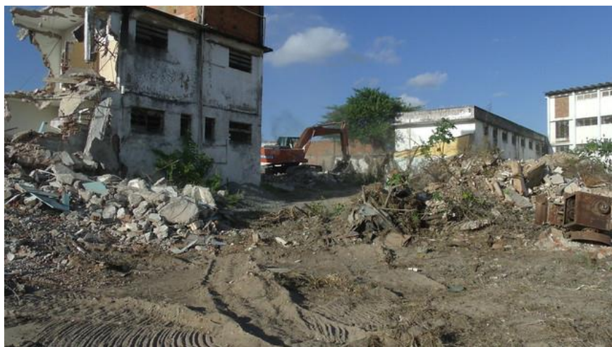
Figura 11 - Demolição do Hospital João Ribeiro | Fonte: https://sesuma.org.br/sesuma-realiza-limpeza-e-servico-de-demolicao-no-antigo-hospital-joao-ribeiro/
