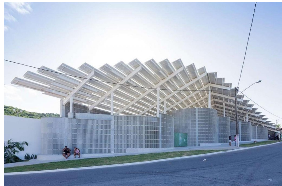
Figura 34 - Construção do telhado | Fonte: Archdaily
