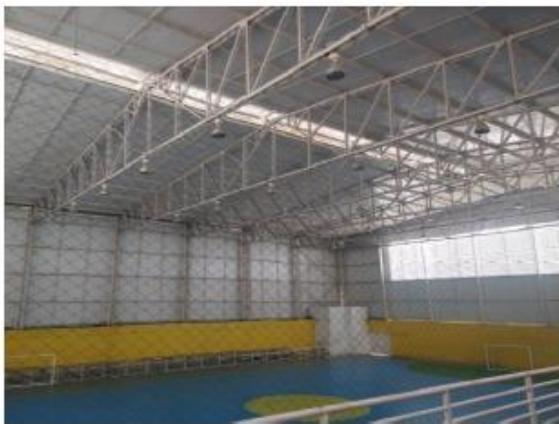
Figura 22 - Lanternim na cobertura do ginásio | Fonte: Wilson Silva
