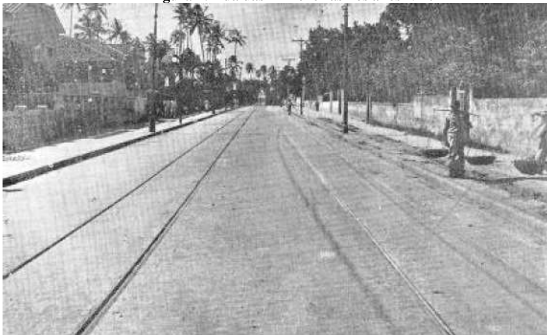
Figura 4: Rua das Trincheiras nos anos 1940
