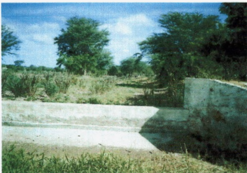
Foto 10: Sangradouro de barragem subterrânea.
