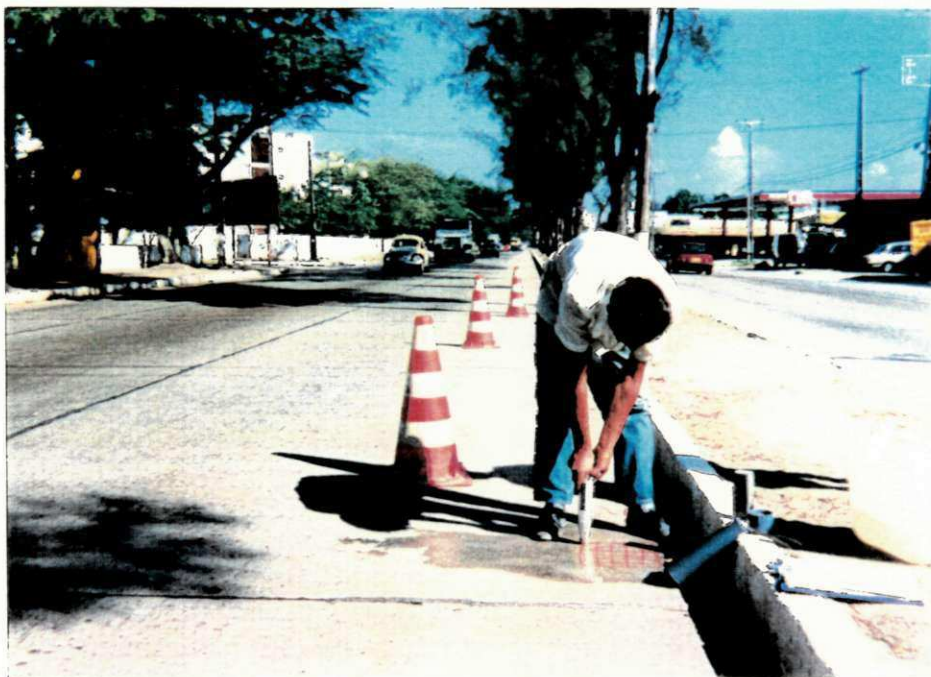
Fig. 42 - Av. Recife - Ensaio Esclerométrico na Pista de Rolamento (1991).
