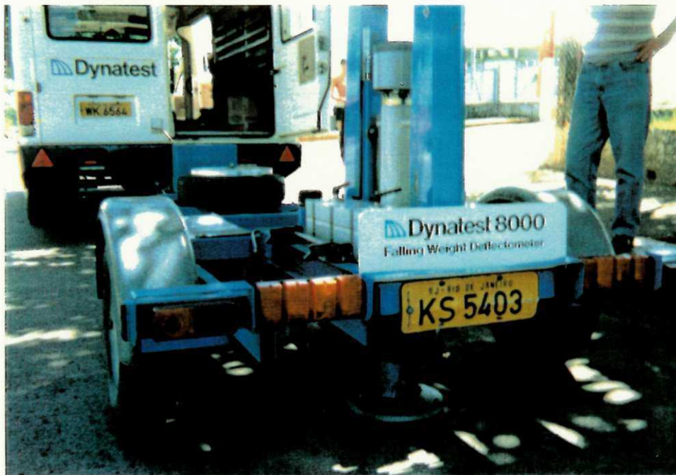
Fig. 79 - Av. Recife - Ensaio com o "FWD" Vendo-se Detalhe da Aplicação da Carga sobre o Pavimento (Maio/92).
