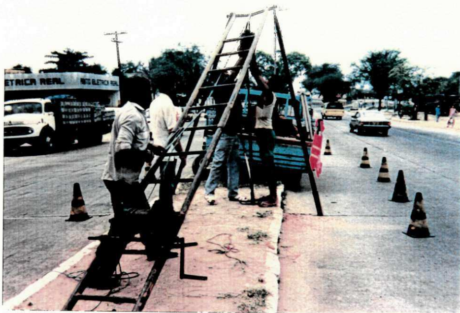
Fig. 35 - Av. Recife - Ensaio de Sondagem SPT Realizado no Canteiro Central (1991).
