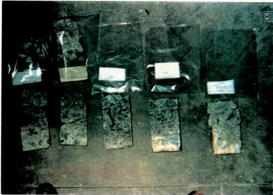
Fig. 61 - Carbonatação Visível a partir da Face Superior dos Testemunhos Extraídos (Parte Inferior na Foto). Vê em-se também a Identificação e o Acondicionamento de Amostras para o Ensaio de Reconstituição do Traço.
