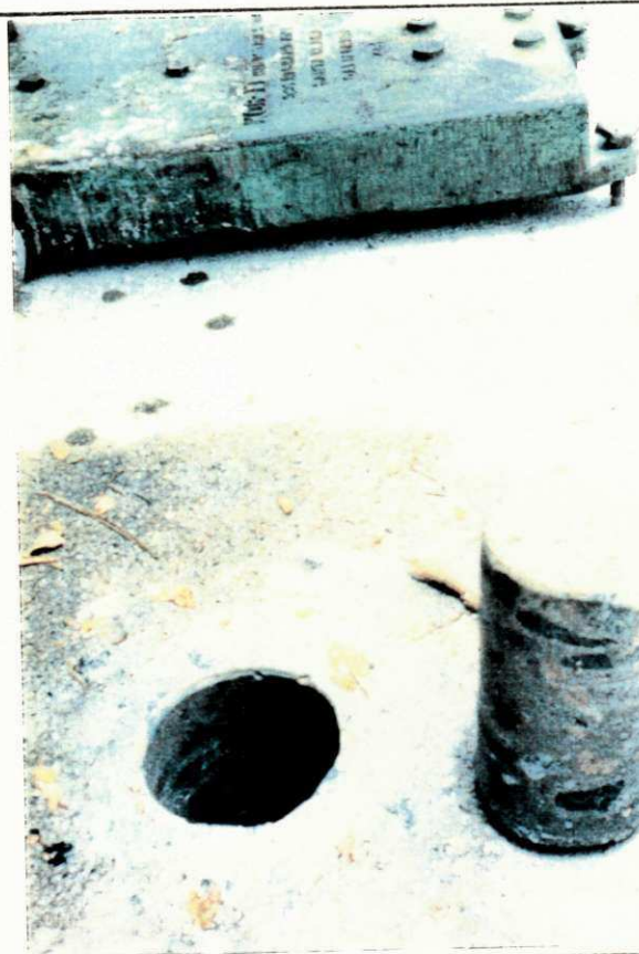
Fig. 39 - Av. Recife - Detalhe do Testemunho Extraído (1991).
