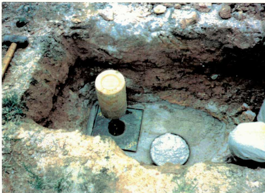
Fig. 19 - Av. Recife - Ensaio de Massa Específica Aparente "In Situ" no Subleito, Realizado no Canteiro Central (1990).
