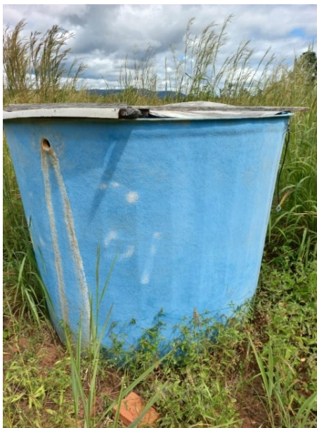
Figura 5 - Caixa d'água de 10.000 Litros
