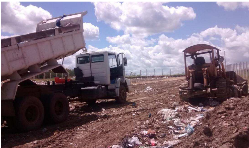
Figura 8: Máquinas de força para fazer o aterramento dos resíduos sólidos
