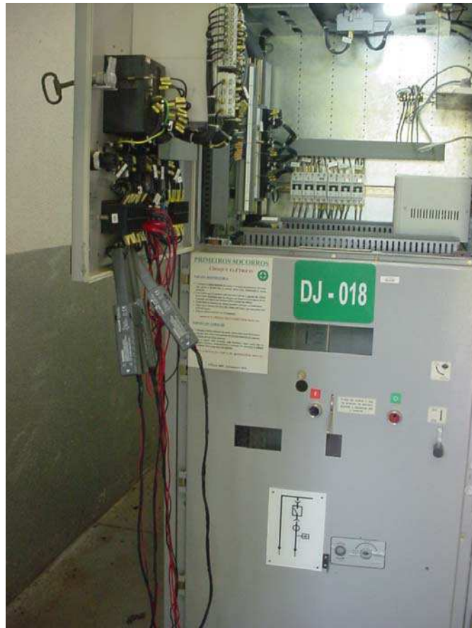
Figura A.4 – Fotografia do arranjo da medição dos sinais de tensão e corrente nos terminais dos relés de disjuntores.
