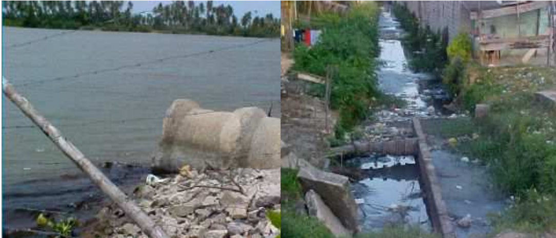
Figuras 4.57: (a) e (b) Lançamento de esgoto residencial na Lagoa Mundaú.
