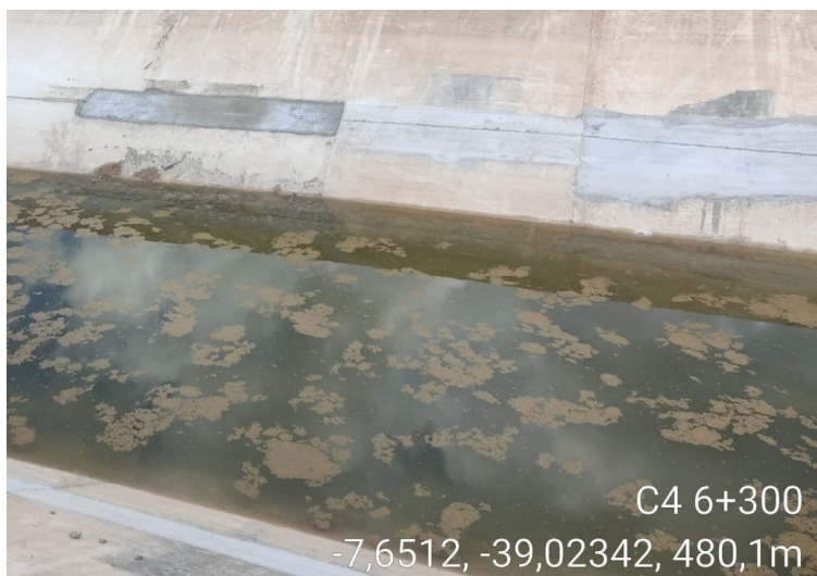
Foto 17 - Recomposição de revestimento em placas de concreto.
