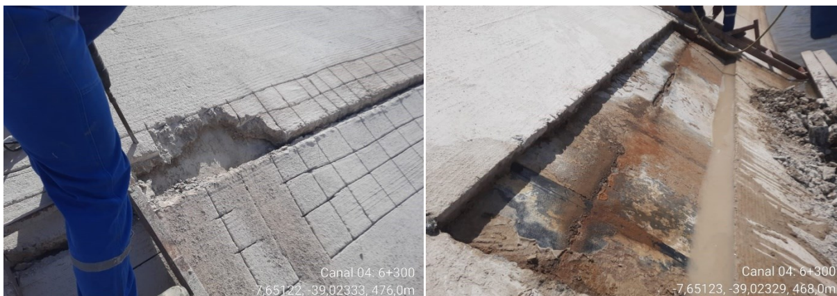
Foto 16 - Demolição de placas na linha da junta longitudinal.
