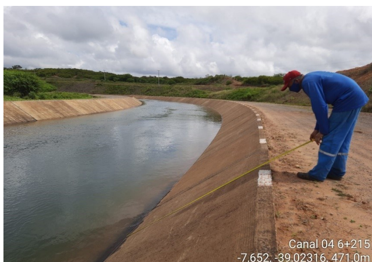
Foto 1 - Medição do talude (borda livre) para cálculo do N.A. do canal.
