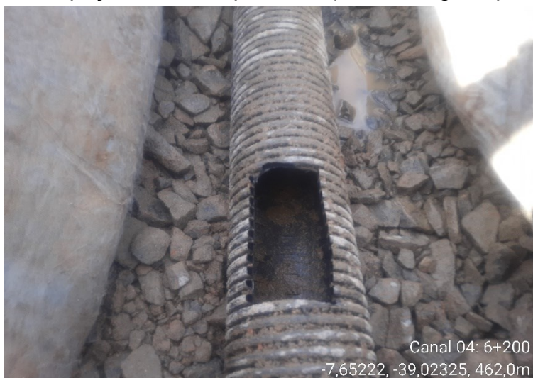
Foto 12 - Inspeção de dreno profundo (tubo corrugado perfurado).
