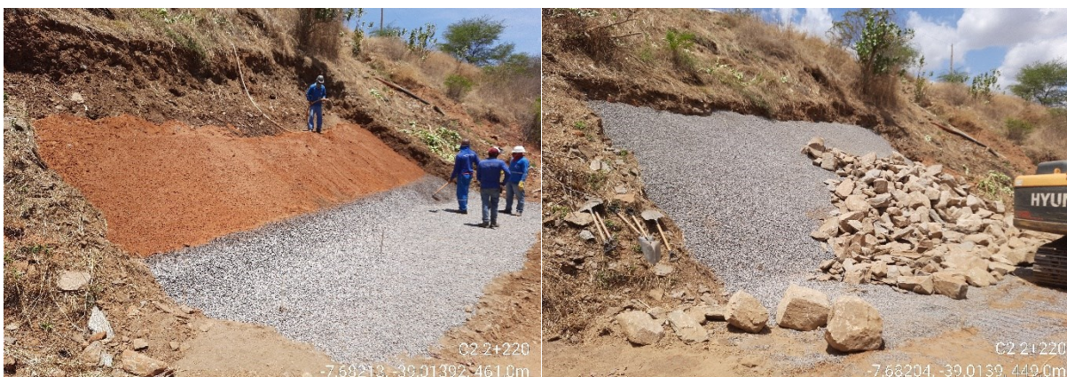
Foto 15 - Processo construtivo do rockfill em áreas de saturação e piping .
