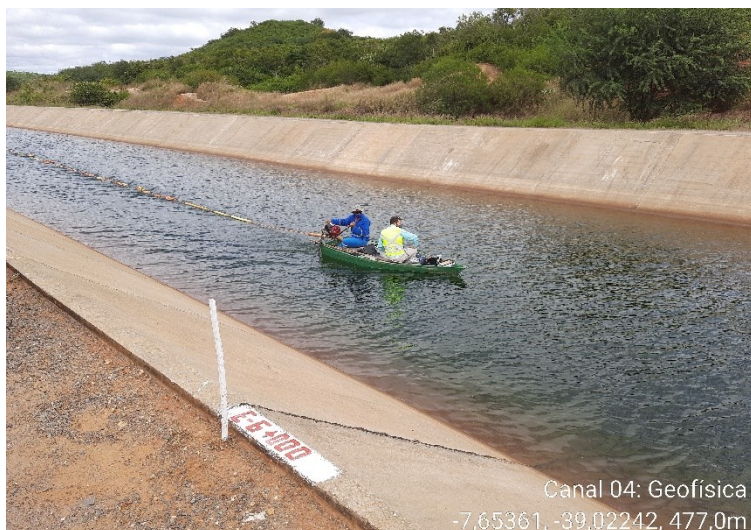
Foto 19 - Inspeção geofísica dos canais para detecção de vazamentos.
