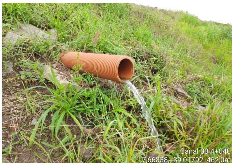
Foto 4 - Saída de dreno ativa.
