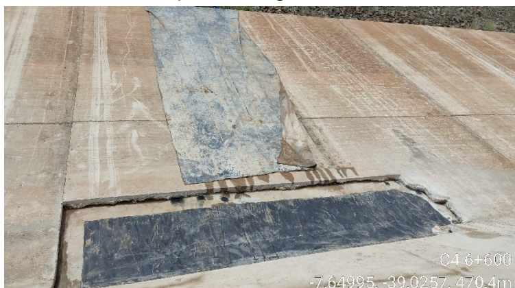
Foto 13 - Reparo com geomembrana nova.
