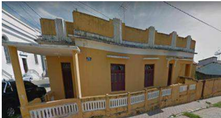
Figura 3 - Fachada da edificação
