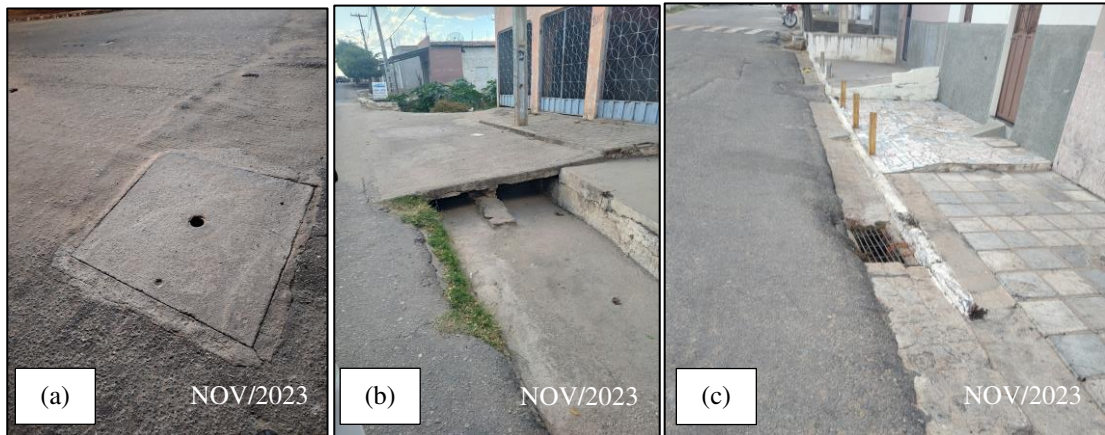
Figura 34 - (a) Poço de visita na rua Euclides Franco; (b) Boca de lobo na rua Antônio Félix; (c) Boca de lobo e meio-fio na rua Pedro Saraiva Moura.
