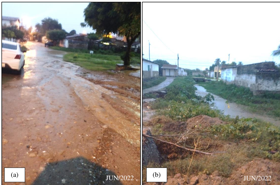
Figura 36 - Processos erosivos em trechos não pavimentados das ruas (a) José Urquiza Carneiro e (b) Luiz Marinho dos Santos.
