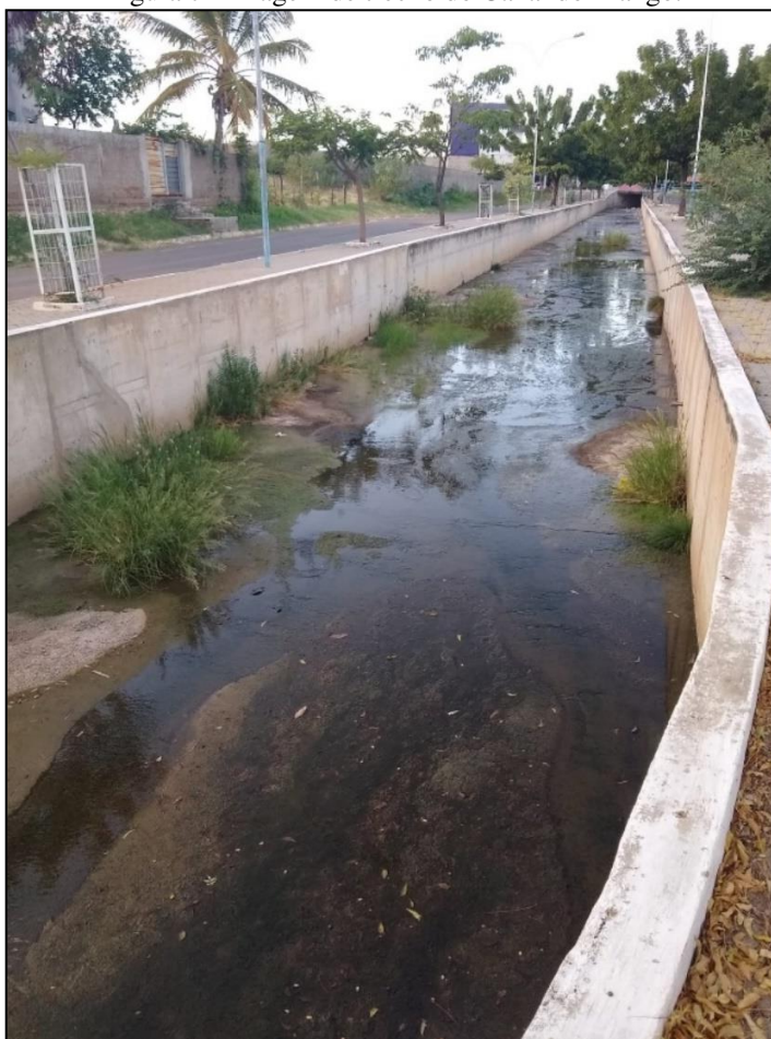
Figura 7 - Imagem de trecho do Canal do Frango.
