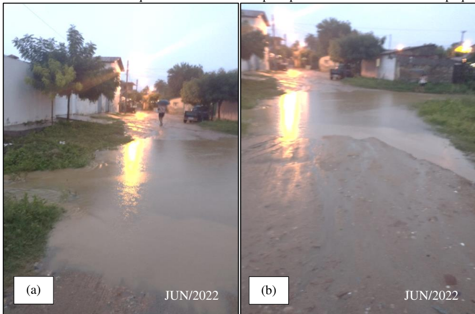
Figura 31 - Acesso da rua José Urquiza Carneiro interrompido por falta de bueiro celular ou pequena ponte.
