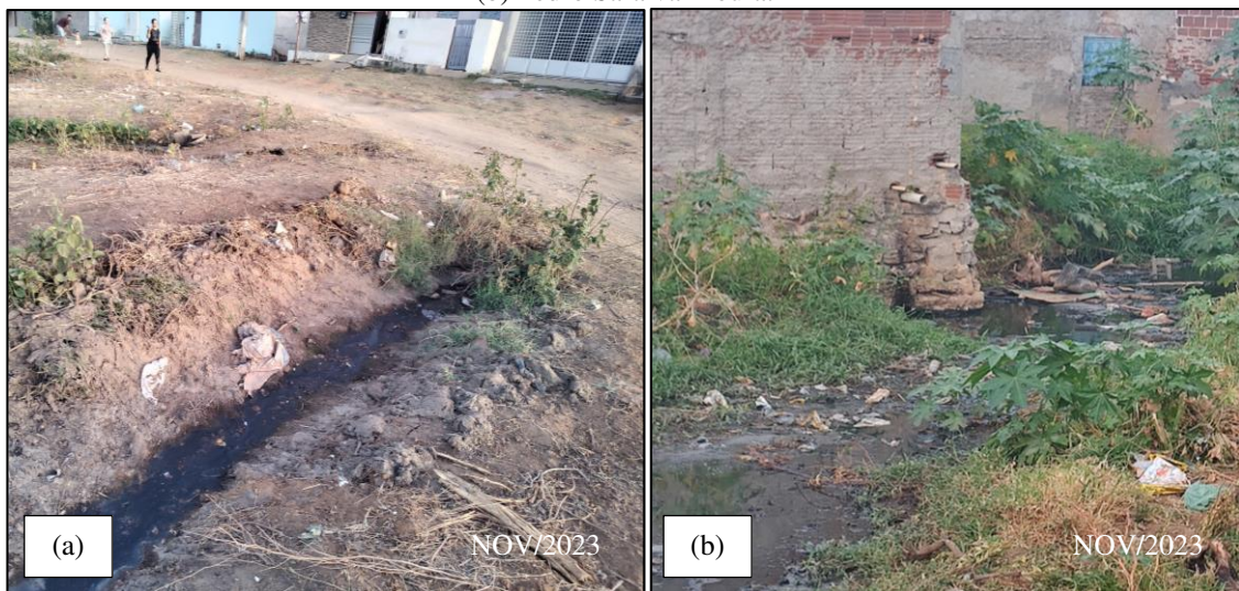
Figura 29 - Lançamento irregular de efluentes domésticos e comerciais nas ruas (a) João Mariano de Oliveira e (b) Pedro Saraiva Moura.
