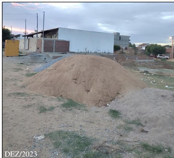
Figura 19 - Residências construídas no leito do Riacho São Sebastião na rua Alameda Canal.
