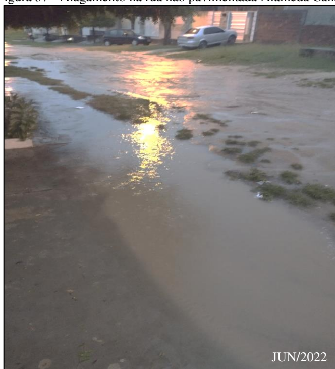
Figura 37 - Alagamento na rua não pavimentada Alameda Canal.
