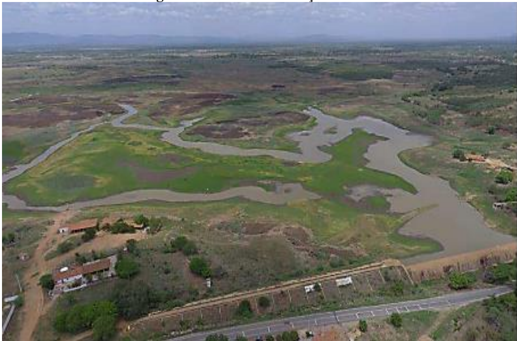
Figura 4 - Vista aérea do Açude Pilões.
