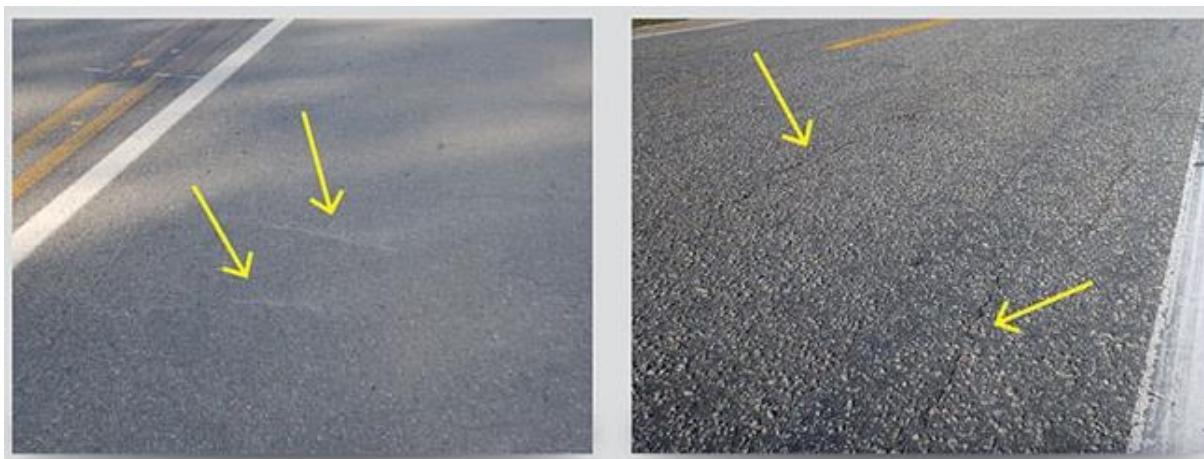
Figura 5 - Fissuras
