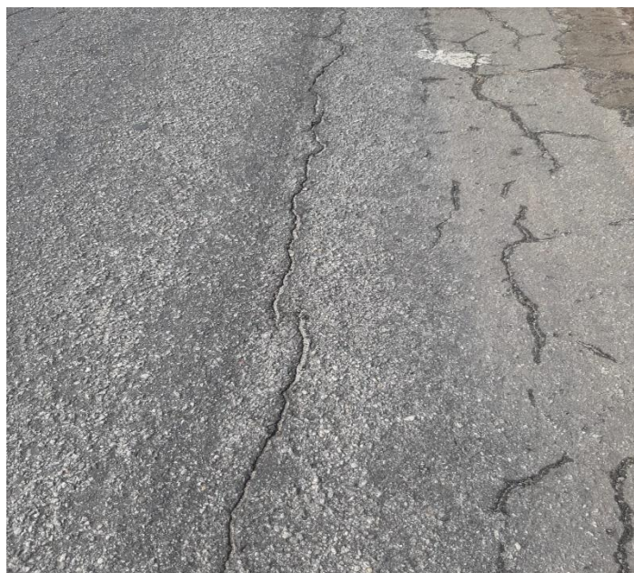
Figura 6 - Trincas Isoladas
