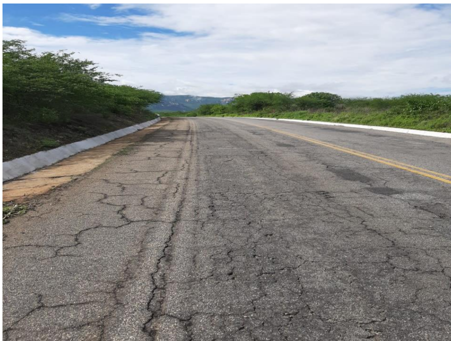
Figura 21 - Trincas isoladas
