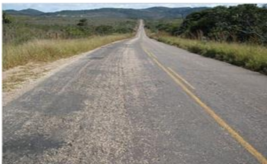
Figura 12 - Desgaste
