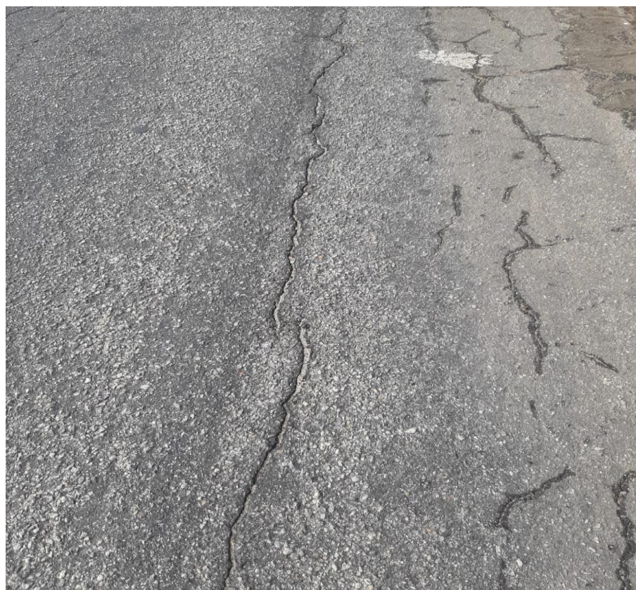
Figura 22 - Trincas Longitudinais
