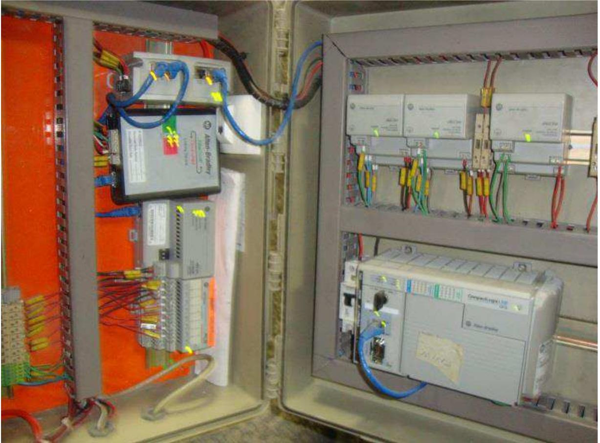
Figura 2. 13 - Painel de automação contendo o Controle Lógico Programável (CLP).
