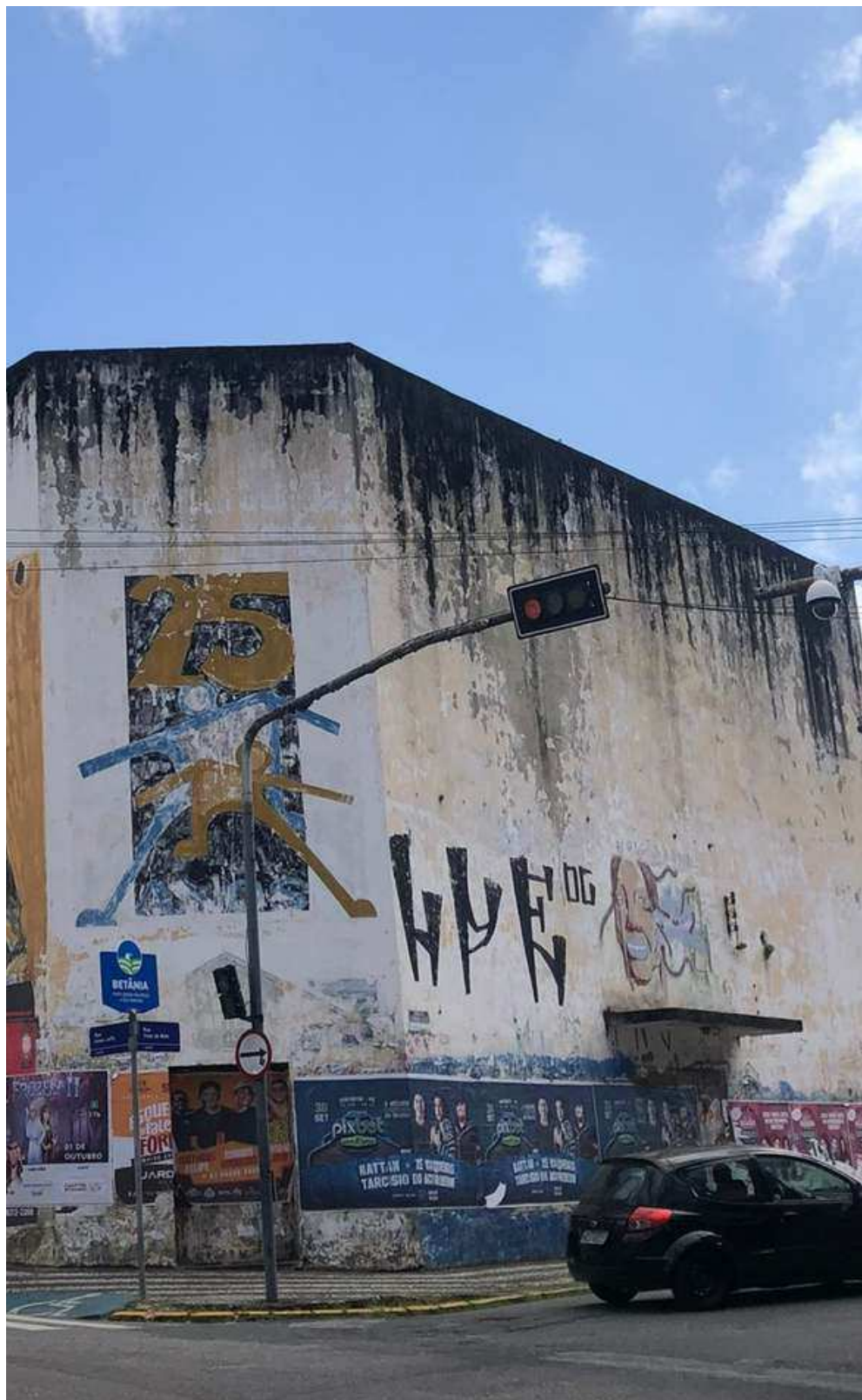
CROSTA NEGRA NA FACHADA SUL. FONTE: MIRELLA DARLANA (2023)
