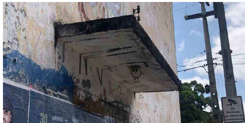
MARQUISE DA FACHADA SUL. FONTE: MIRELLA DARLANA (2023)
