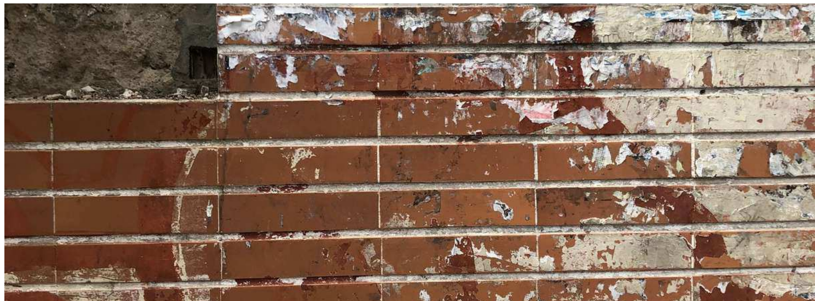
Fig. 17 | Revestimento em tijolinhos da fachada principal da edificação. Fonte: Autora (2023)
