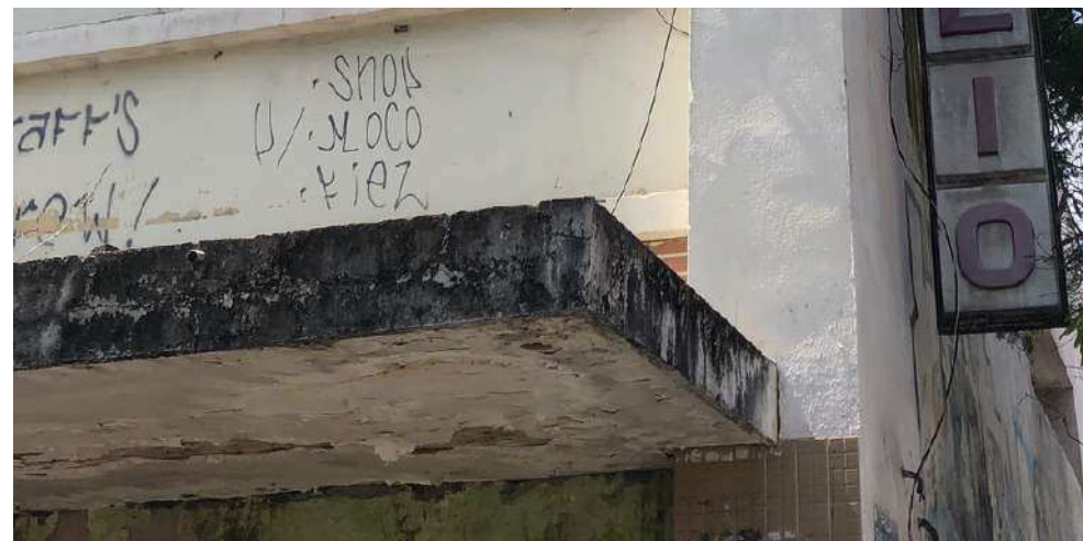
MARQUISE DA FACHADA NORTE. FONTE: MIRELLA DARLANA (2023)
