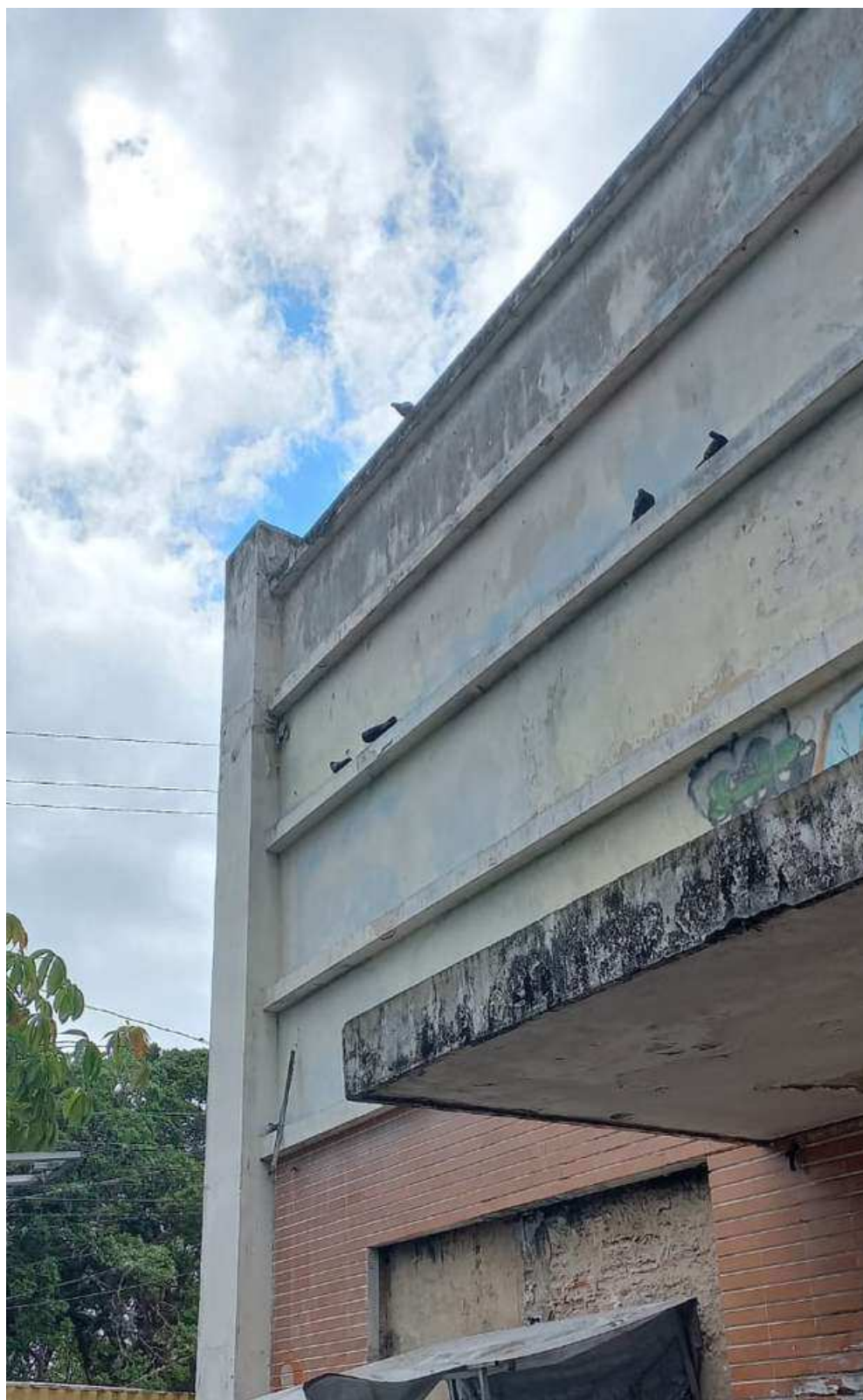
EFLORESCÊNCIA EM ELEMENTOS DA FACHADA NORTE. FONTE: MIRELLA DARLANA (2023)
