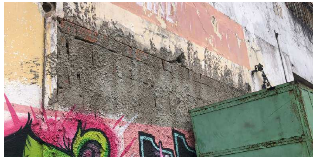
OBSTRUÇÃO DE ABERTURA POR AÇÃO POSTERIOR FONTE: MIRELLA DARLANA (2023)
