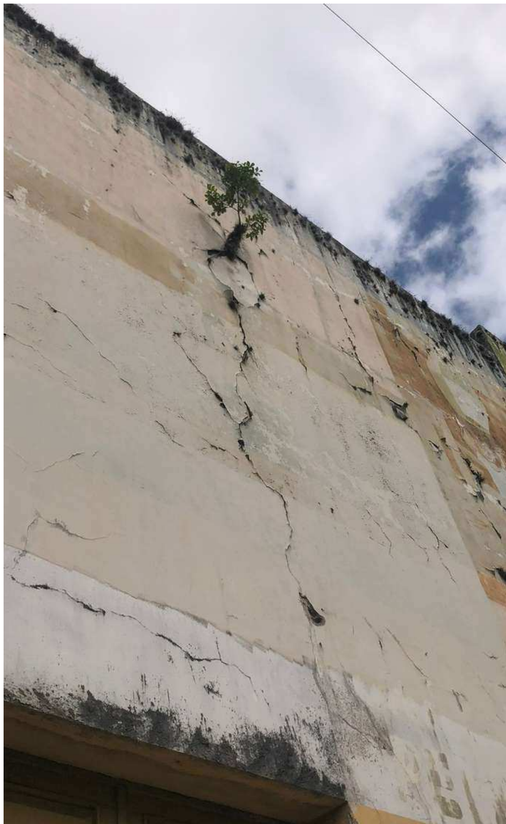
FISSURAS NA FACHADA LESTE. FONTE: MIRELLA DARLANA (2023)
