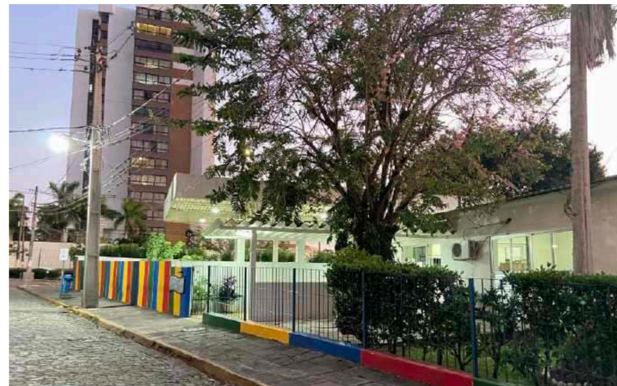
[Figura 50]: Vista Entrada UAEI- UFCC. Fonte: Autora, 2023.
