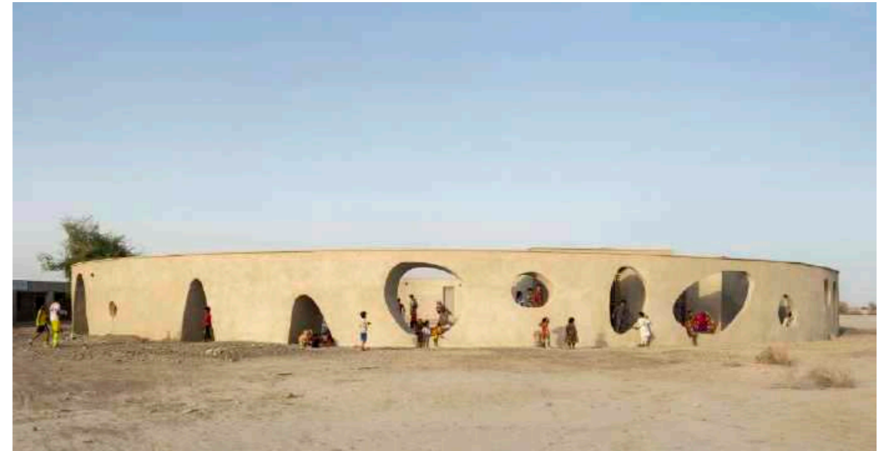
[Figura 10]: Vista frontal da escola. Fonte: Deed Studio.
