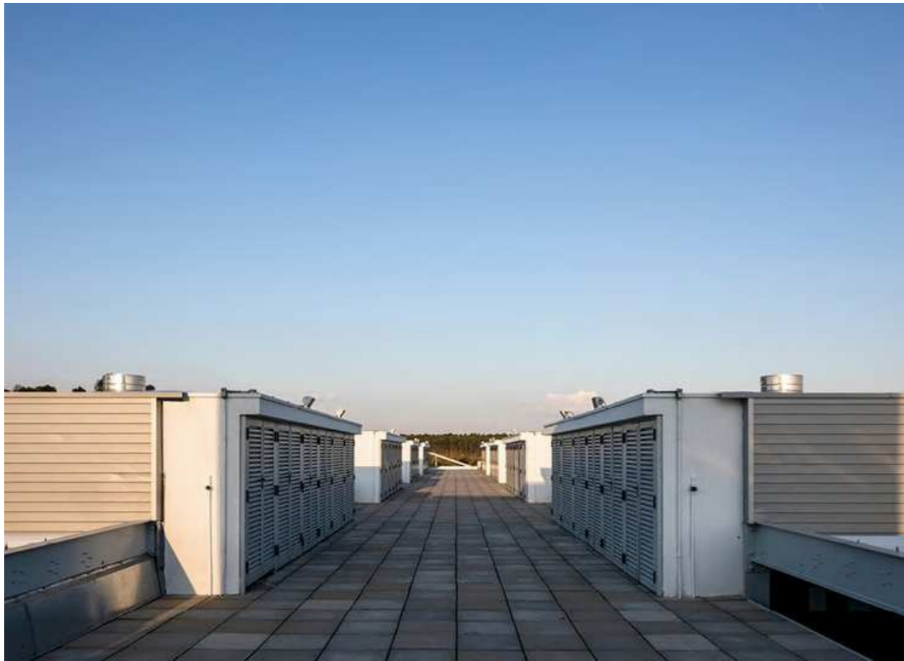
▲ Figura 17: Rua de Maquinas. Fonte: Archdaily. (2023).
