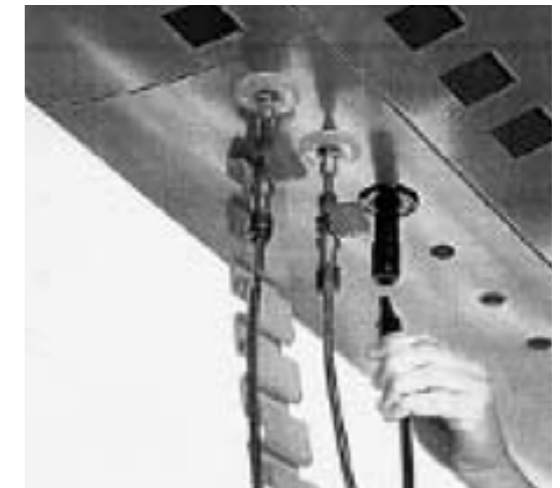
Figura 05: Conexão fácil e desconexão de serviços de engenharia permitem para pronta reconfiguração de o laboratório. Fonte: WATCH, 2001, p. 26.
