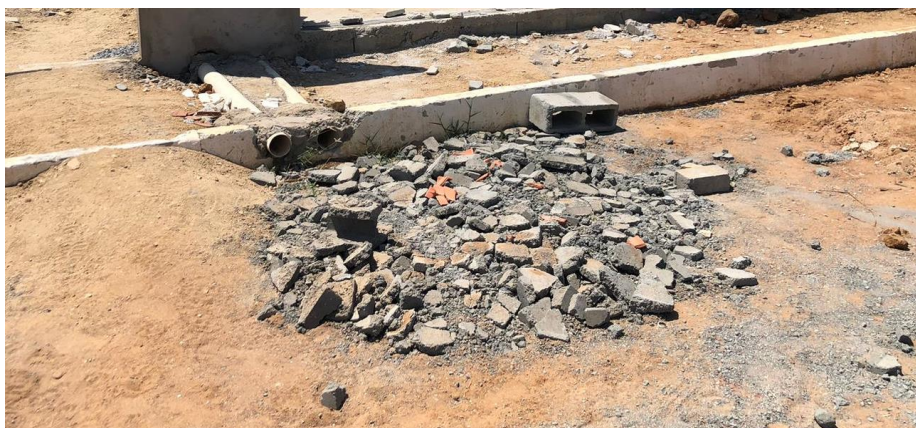
Figura 8 – Reutilização de blocos de concreto na construtora 3
