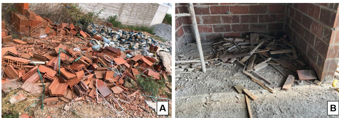
Figura 4 – Acondicionamento de RCD nas obras da Construtora “1”
