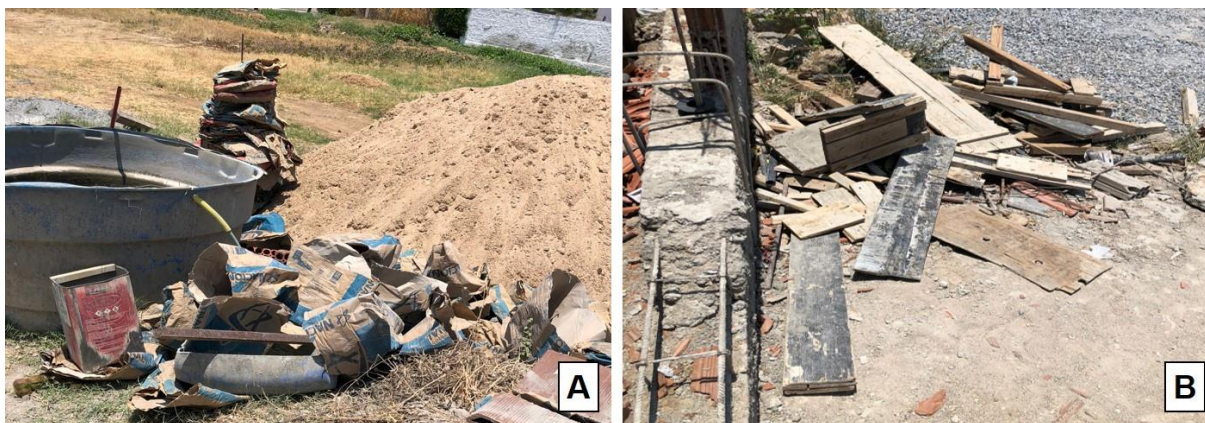
Figura 5- Acondicionamento de RCD nas obras da Construtora “2”
