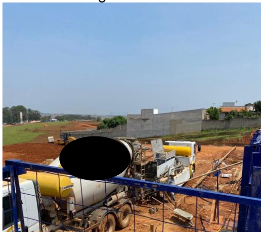
Figura 18 – Montagem da bomba estacionária.
