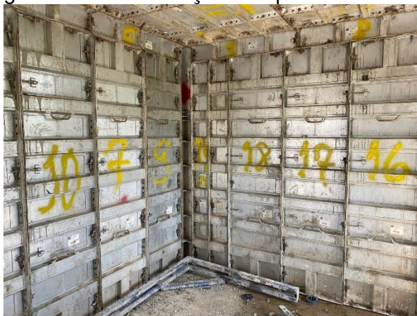
Figura 08 – Identificação dos painéis de forma
