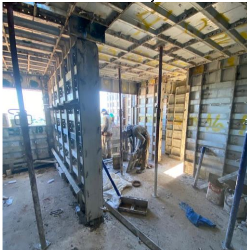
Figura 13 – Painéis de laje e escoramento.
