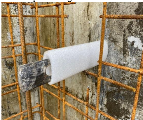
Figura 11 – Colocação das gravatas e camisas protetivas.
