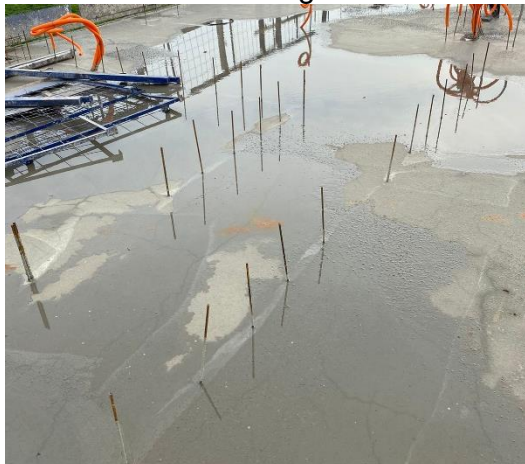
Figura 27 – Cura da concretagem realizada com água.
