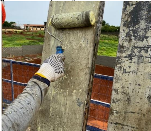
Figura 09 – Aplicação de desmoldante.
