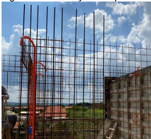
Figura 05 – Armação das paredes.
