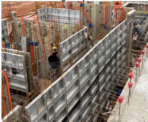
Figura 10 – Montagem painéis de alumínio.
