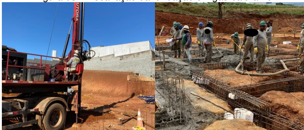
Figura 03 – Escavação da fundação e vigas baldrame.
