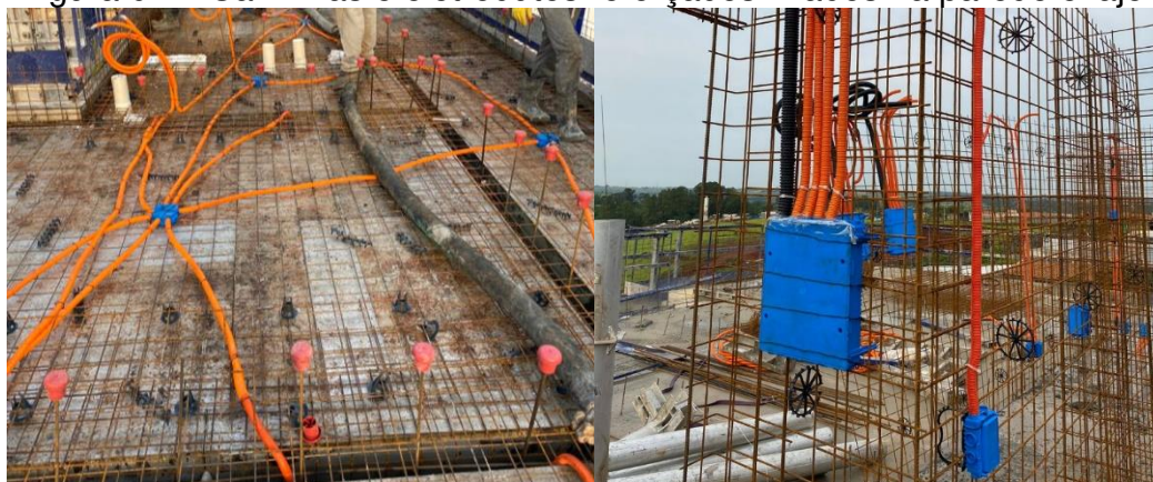
Figura 07 – Caixinhas e eletrodutos reforçados fixados na parede e laje.
