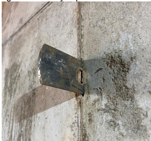
Figura 31 – Peças presas no concreto.
