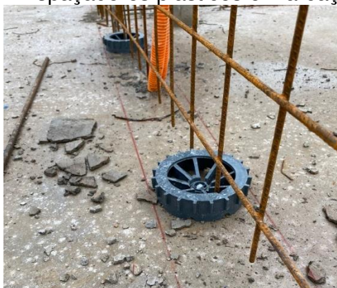
Figura 04 – Espaçadores plásticos e marcação da laje.
