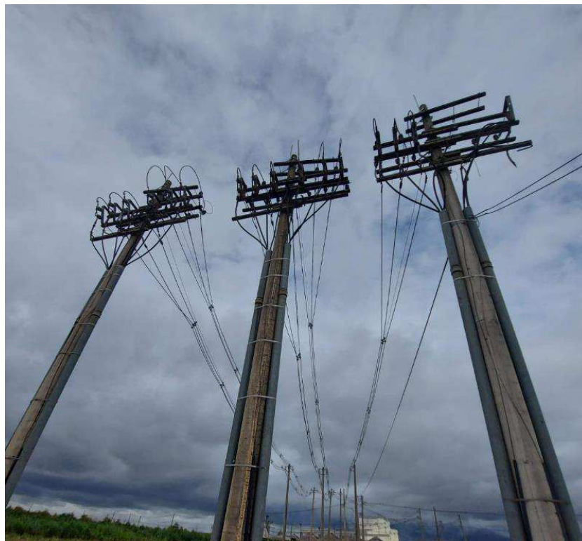
Figura 21 - Ramais de saída da subestação principal antes da melhoria
