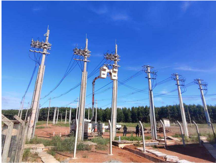
Figura 22 - Ramais de saída da subestação principal durante obra dos leitos subterrâneos
