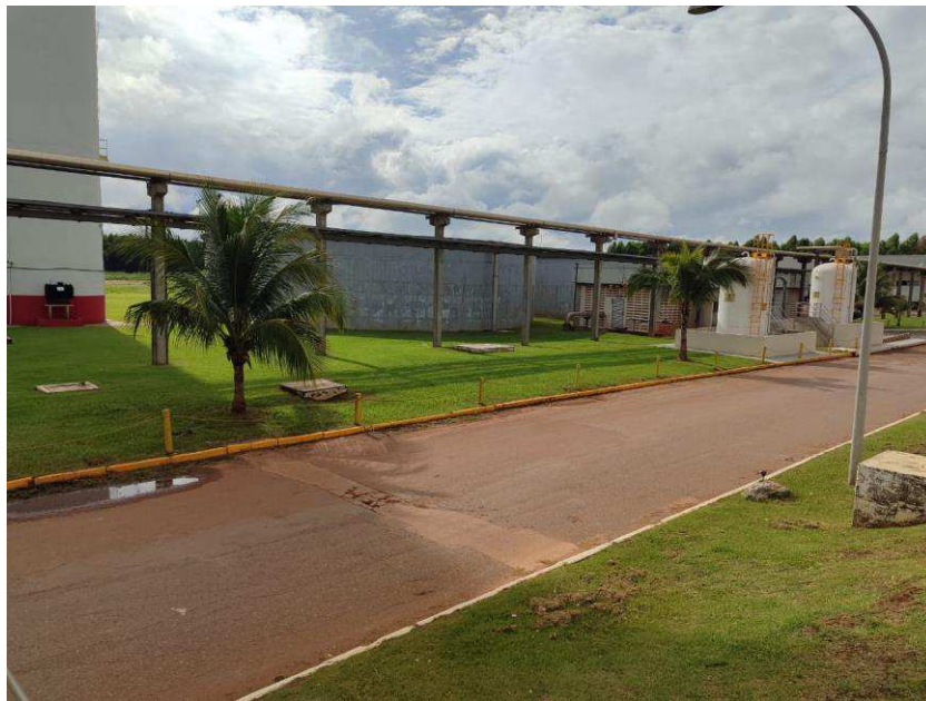
Figura 8 - Estação de tratamento de água
