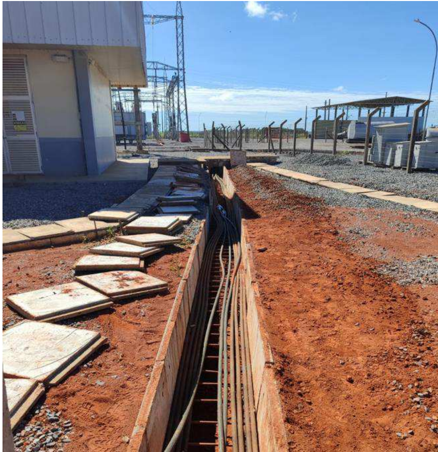
Figura 23 - Leitos dos cabos durante a obra
