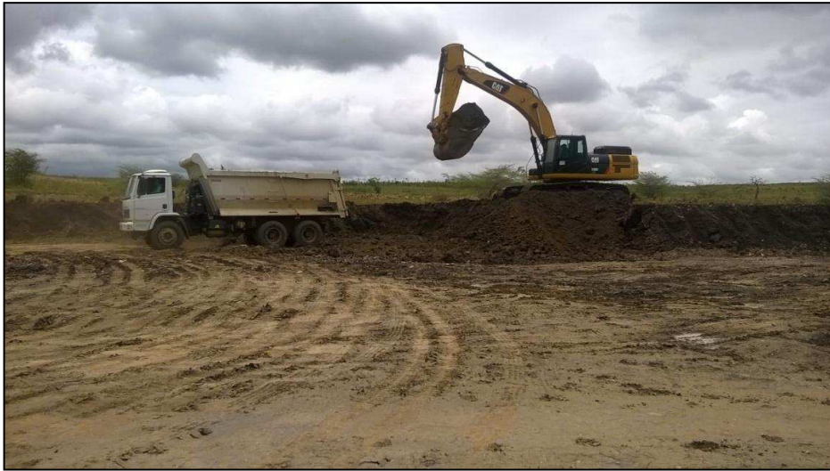
Figura 24 - Jazida de solo.
