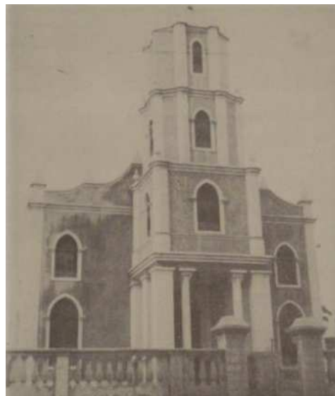
Imagem 2: Primeira reforma do Templo Congregacional.
