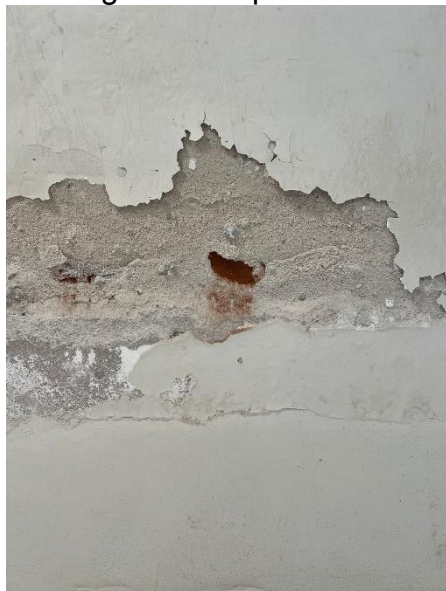
Figura 13 – Eflorescência em alvenaria. Fonte: Autor (2023).
