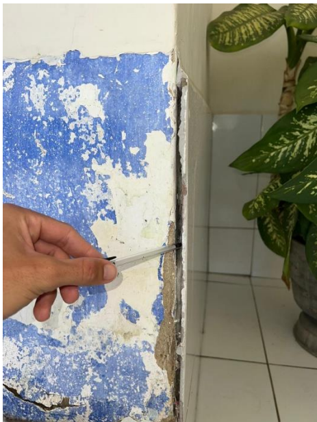
Figura 7 – Desplacamento cerâmico na garagem. Fonte: Autor (2023).
