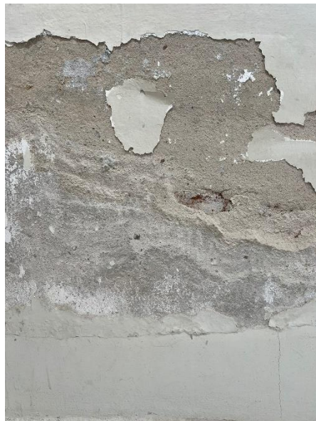
Figura 13 – Eflorescência em alvenaria. Fonte: Autor (2023).
