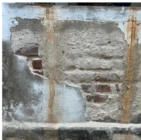
Figura 14– Eflorescência em alvenaria. Fonte: Autor (2023).
