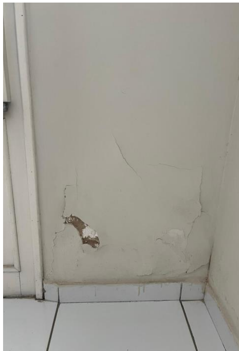
Figura 10 – Descascamento de pintura. Fonte: Autor (2023).
