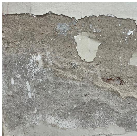
Figura 14– Eflorescência em alvenaria. Fonte: Autor (2023).
