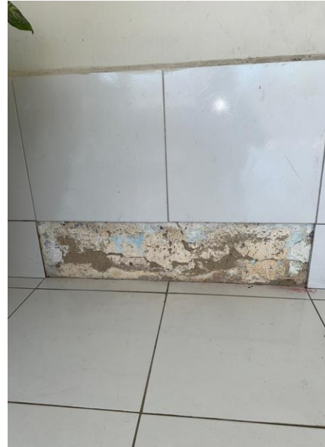
Figura 6 – Desplacamento cerâmico na garagem. Fonte: Autor (2023).
