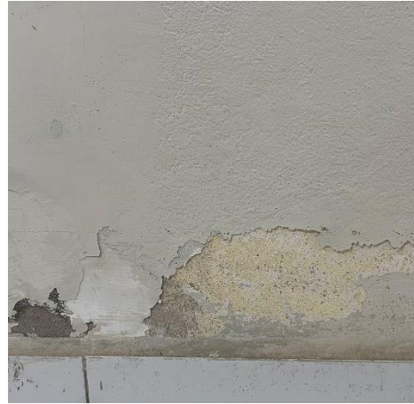
Figura 9 – Descascamento de pintura. Fonte: Autor (2023).
