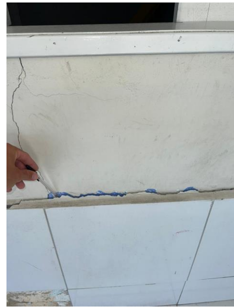
Figura 7 – Desplacamento cerâmico na garagem. Fonte: Autor (2023).
