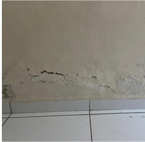
Figura 9 – Descascamento de pintura. Fonte: Autor (2023).
