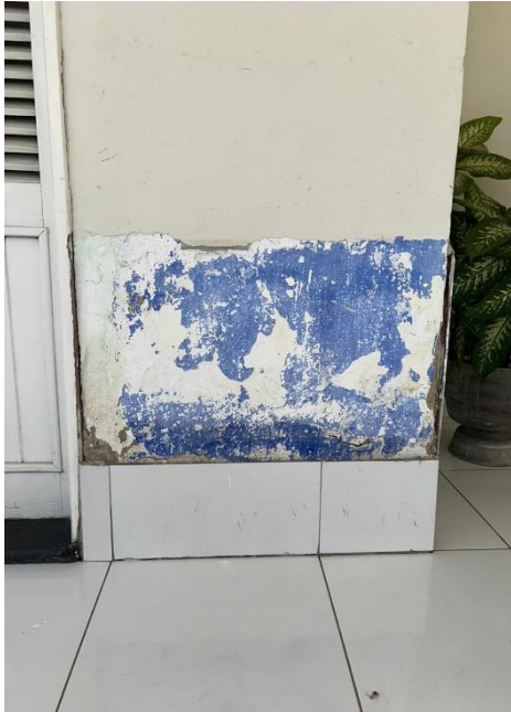
Figura 6 – Desplacamento cerâmico na garagem. Fonte: Autor (2023).
