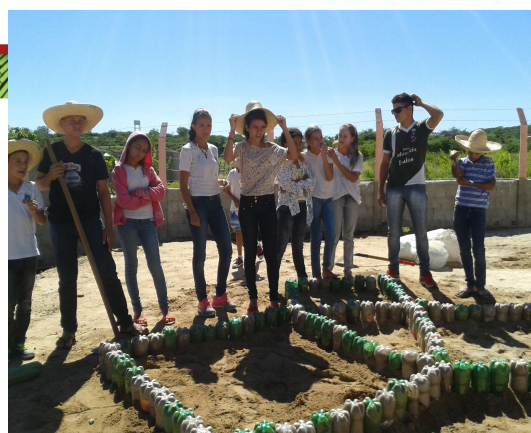
Figura 14. Segunda etapa da construção
