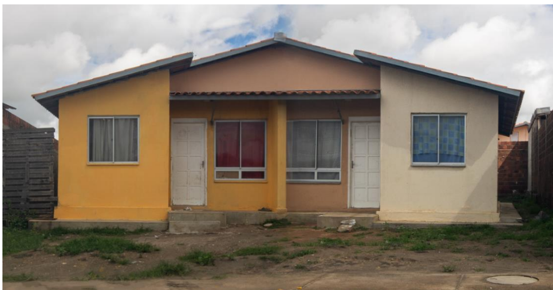
Figura 15 - Fachada casa geminada conjunto Aluízio Campos.
