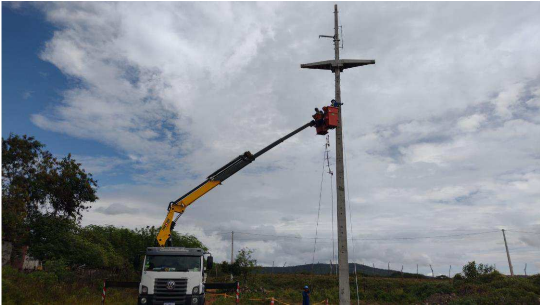
Figura 5.1.3-c Montagem de estrutura tipo RA-PT-PR com pedarólas no poste
