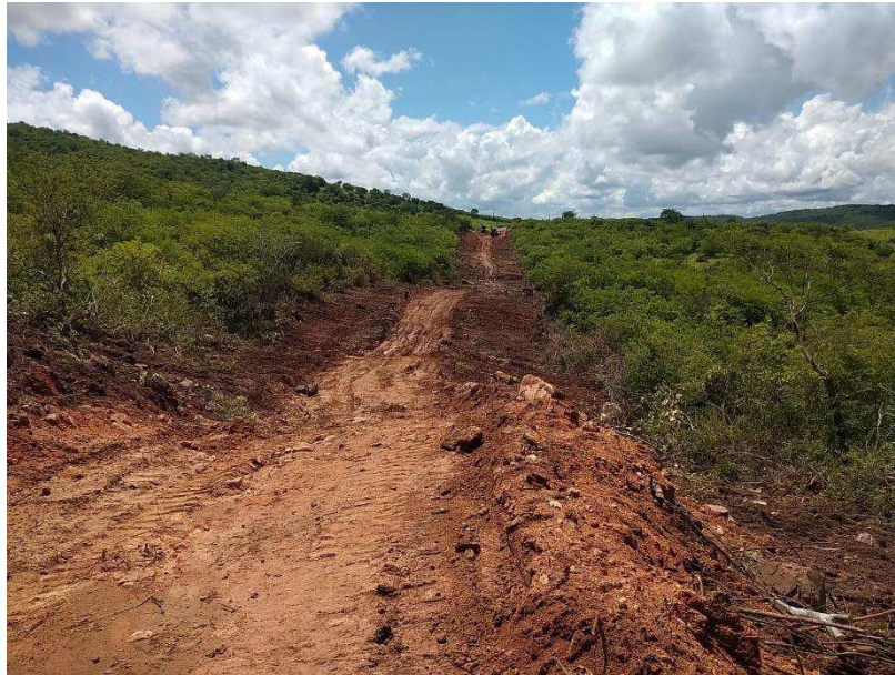
Figura 5.1.1-b Estrada de acesso sendo finalizada
