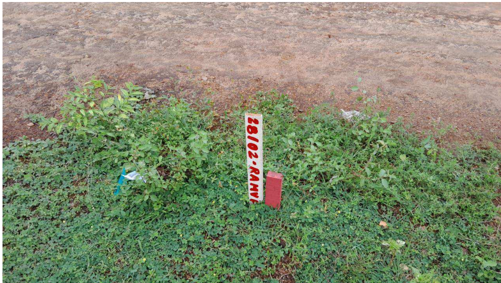
Figura 5.1.1-c Piquete de locação da estrutura 28/02
