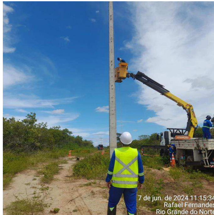
Figura 3.2-a Acompanhamento de Montagem de Estrutura
