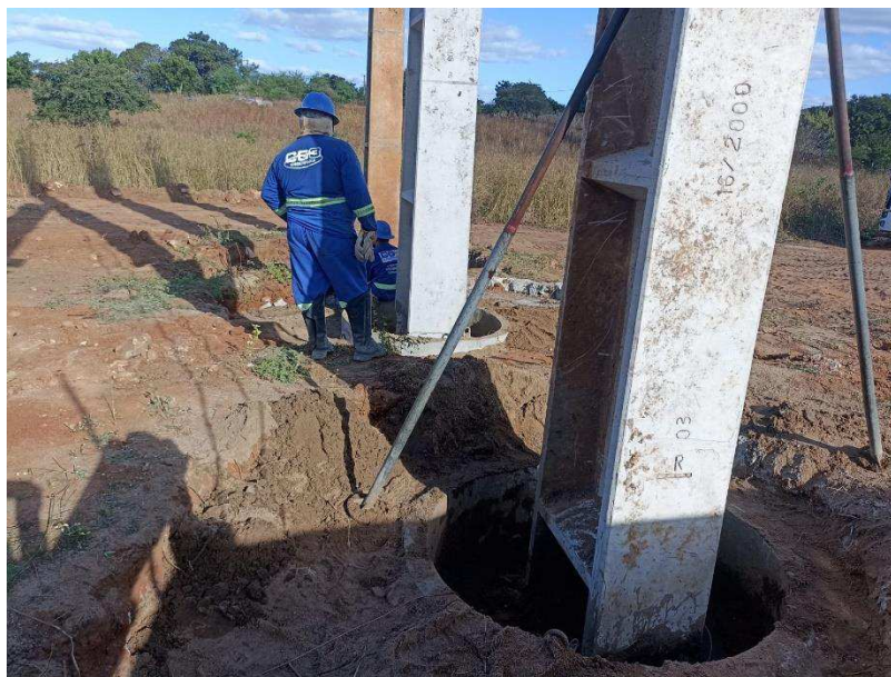
Figura 5.1.3-b Atividade de implantação em estrutura de três postes
