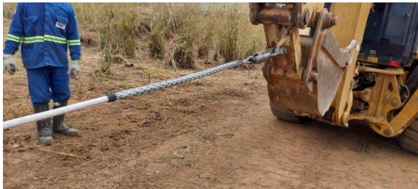
Figura 5.1.4-b Tracionamento de condutor auxiliado por retroscavadeira
