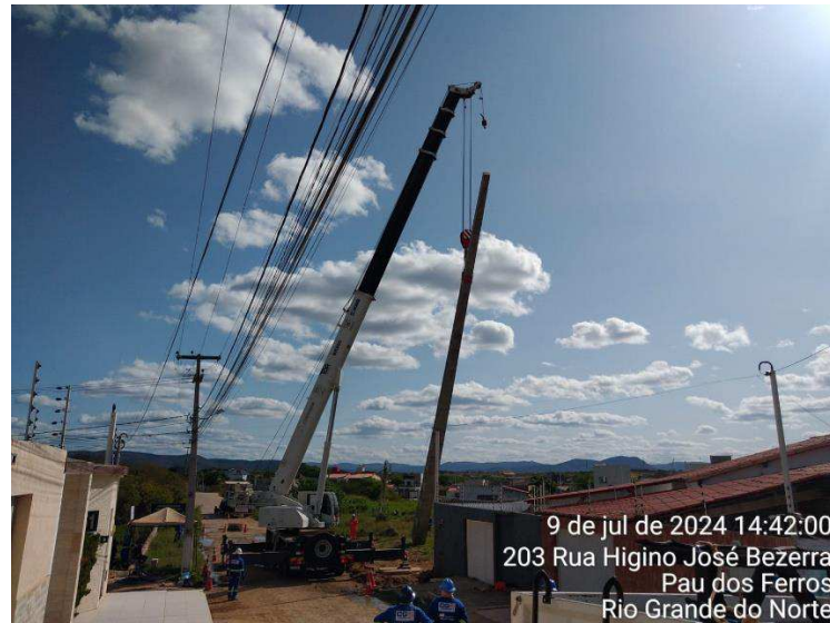
Figura 5.1.3-a Implantação de poste efetuada por guindaste da quarterizada Top Guindastes
