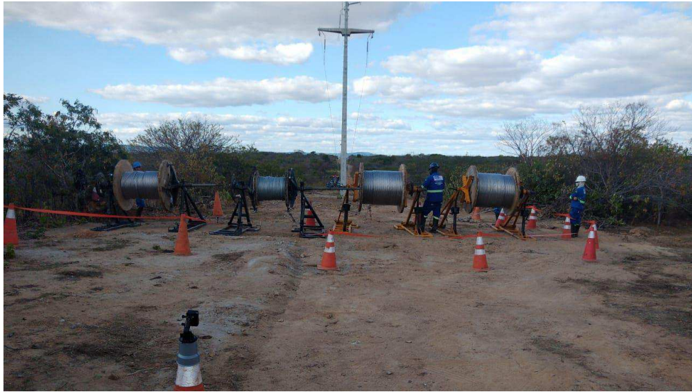
Figura 5.1.4-a Praça de lançamento montada
