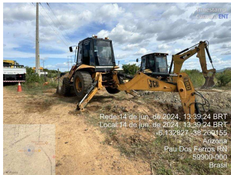
Figura 5.1.2-a Retroescavadeira equipada com rompedor hidráulico fazendo escavação em rocha
