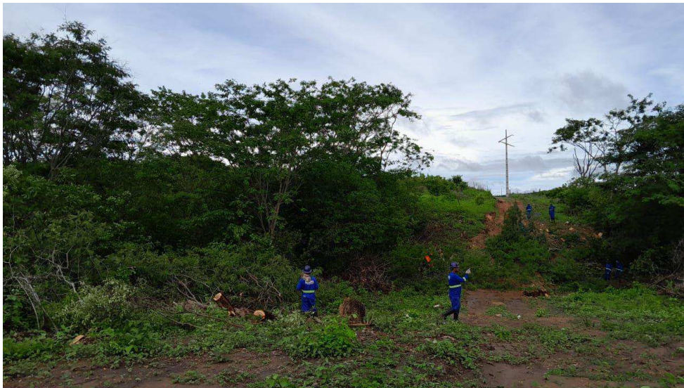
Figura 5.1.1-a Supressão vegetal manual e auxiliada por motosserras
