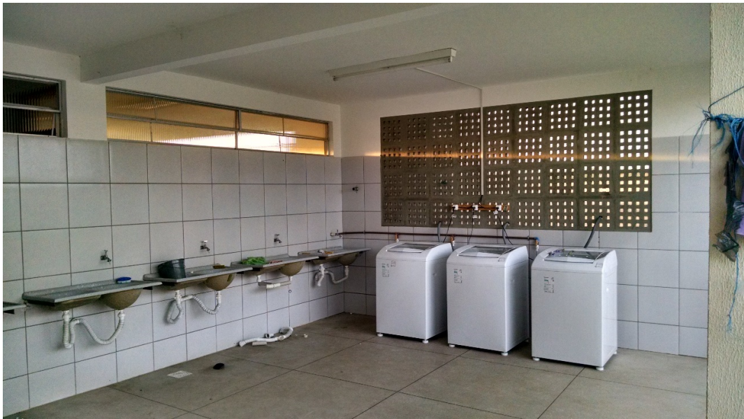
Foto 8 – Área de serviço da residência feminina
