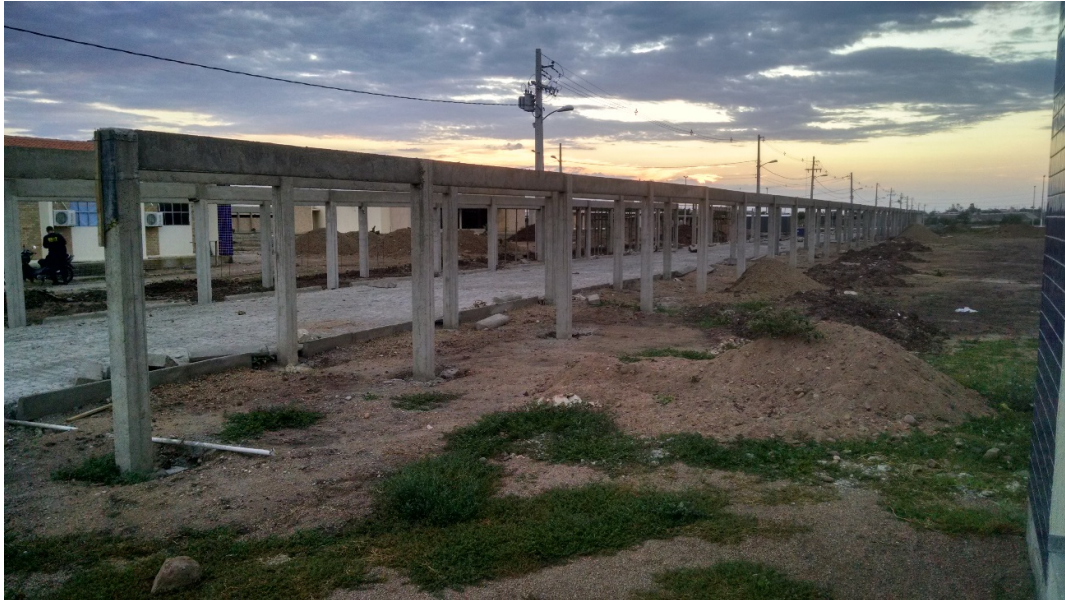
Foto 1 – Passarela para as residências
