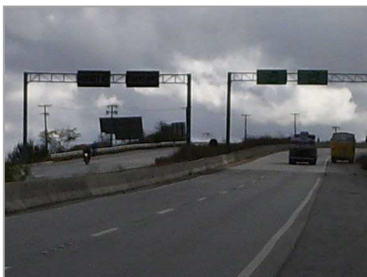
(c) Subida de viaduto do acesso com a BR-423 (acesso a Garanhuns)
