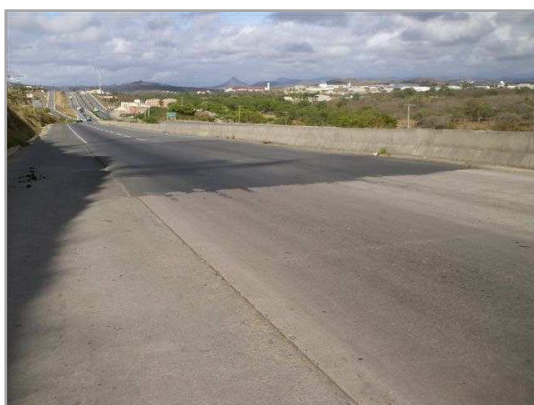
(e) Pista antiga restaurada – acostamento mais estreito (2,5m) do que o novo (3,0m)
