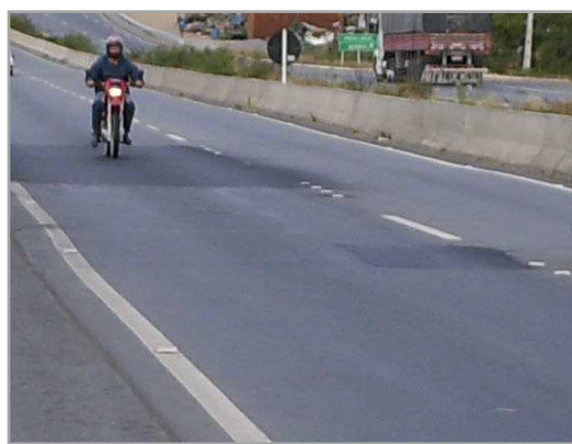
(g) Junção do encontro com a estrutura do viaduto que dá acesso à BR-423 (p/ Garanhuns)
