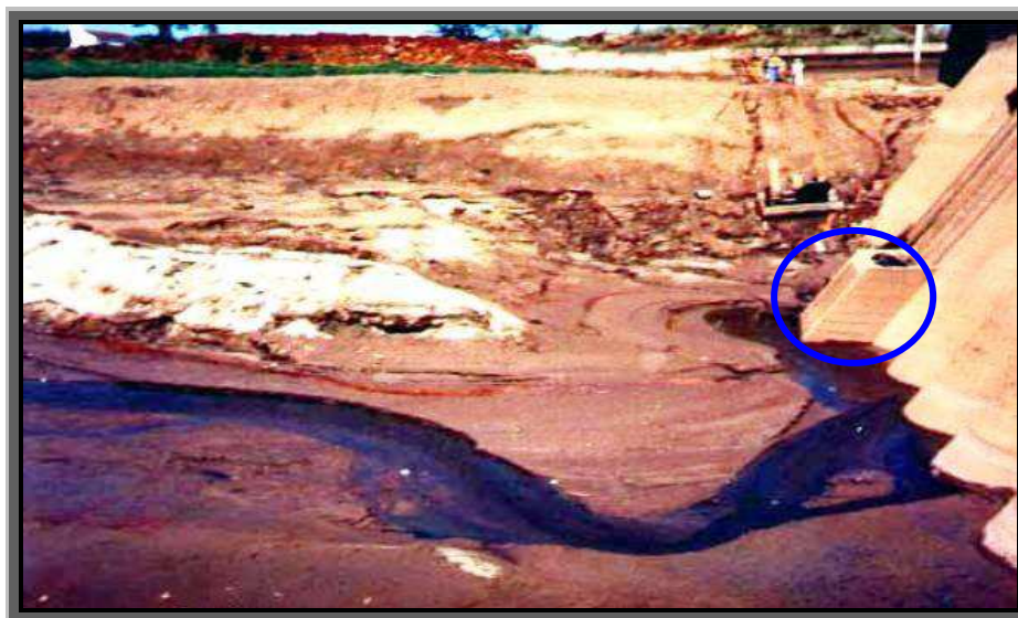
Figura 15. Vista da tomada da água do Reservatório de Cariobinha. Fonte: Coiado (2001).
