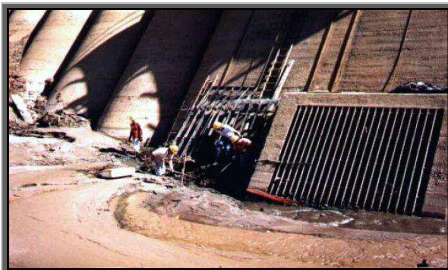
Figura 16. Vista das grades da tomada de água e da comporta de fundo do reservatório de Cariobinha. Início da desobstrução. Fonte: Coiado (2001).
