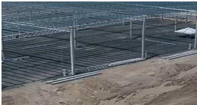
Figura 8: Estruturas de concreto de área do empreendimento Obra A3.
