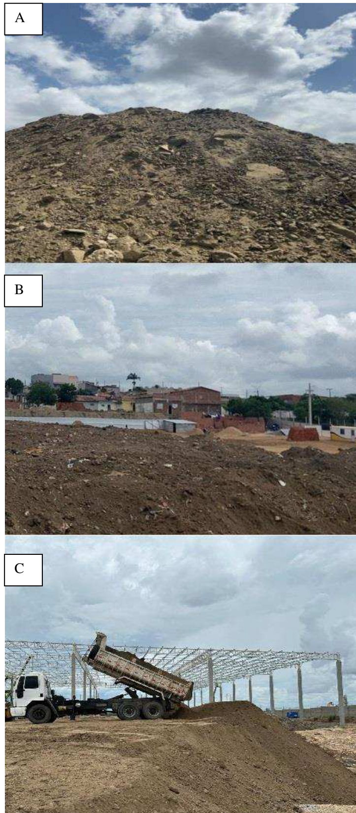
Figura 16: Cobertura de solo argiloso utilizada no desmorte de rocha nas Obras A1 (A), A2 (B) e A3 (C).
