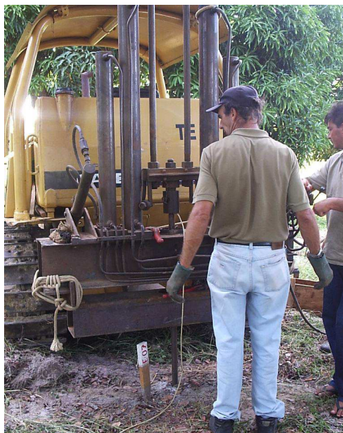
Figura 0.9 - Execução dos ensaios de CPT (com cone tipo Holandês) – posicionamento do equipamento
