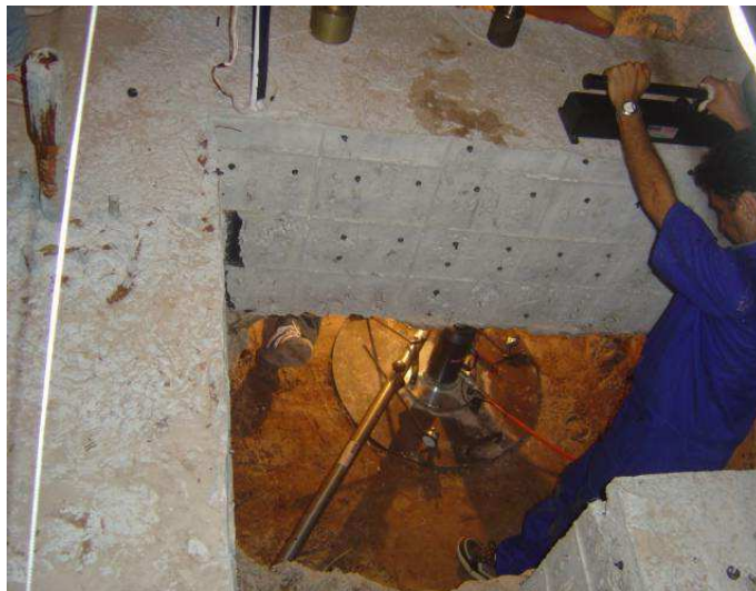
Figura 0.10 - Utilização de uma viga de fundação como reação para o sistema
