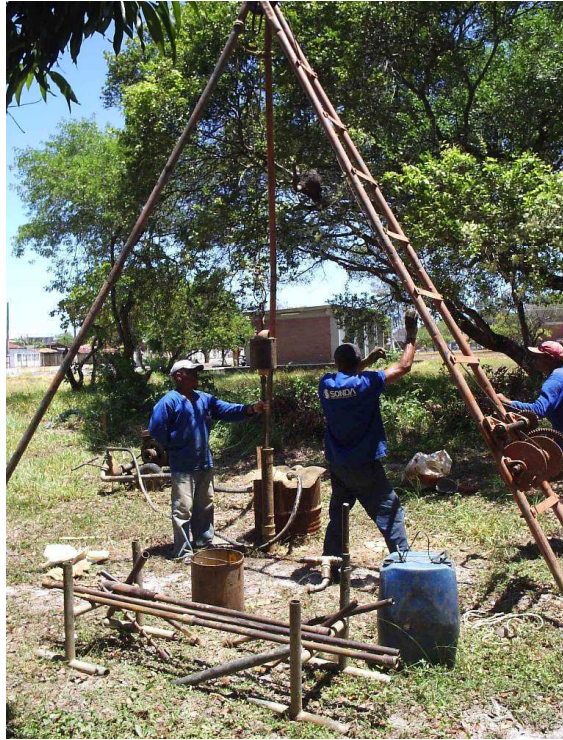
Figura 0.6 – Execução do ensaio das sondagens SPT e SPT-T
