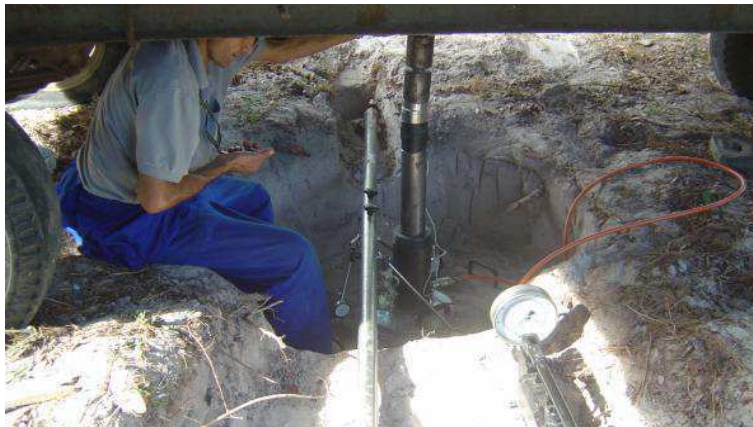
Figura 0.16 - Execução do ensaio de prova de carga estática – aparelhagem do ensaio
