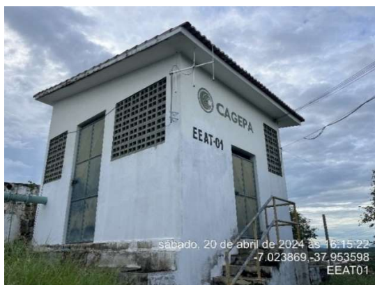
Figura 23 - Estação Elevatória de Água Tratada 1 (EEAT-1)
