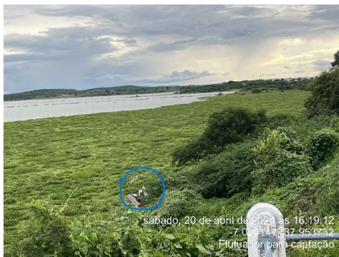
Figura 7 - Flutuador do SAA de Coremas - PB
