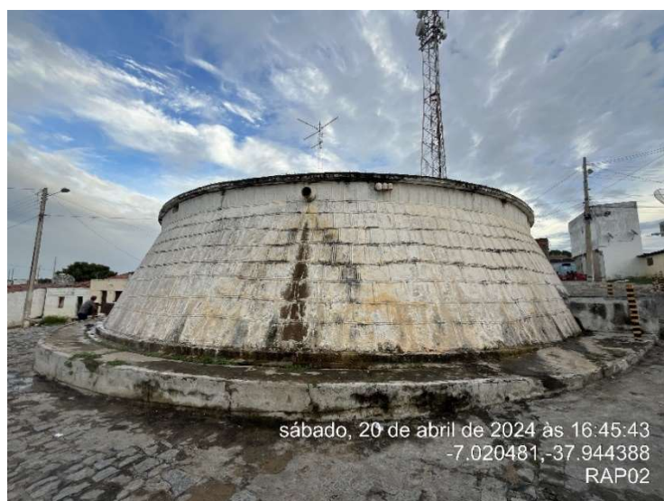
Figura 17 - Reservatório Apoiado 3 de 730 m 3 desativado (RAP3 730 m 3 )
