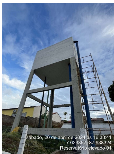
Figura 19 - Reservatório Elevado 1 de 125 m 3 (REL1 125 m 3 )
