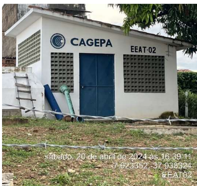
Figura 25 - Estação Elevatória de Água Tratada 2 (EEAT2)
