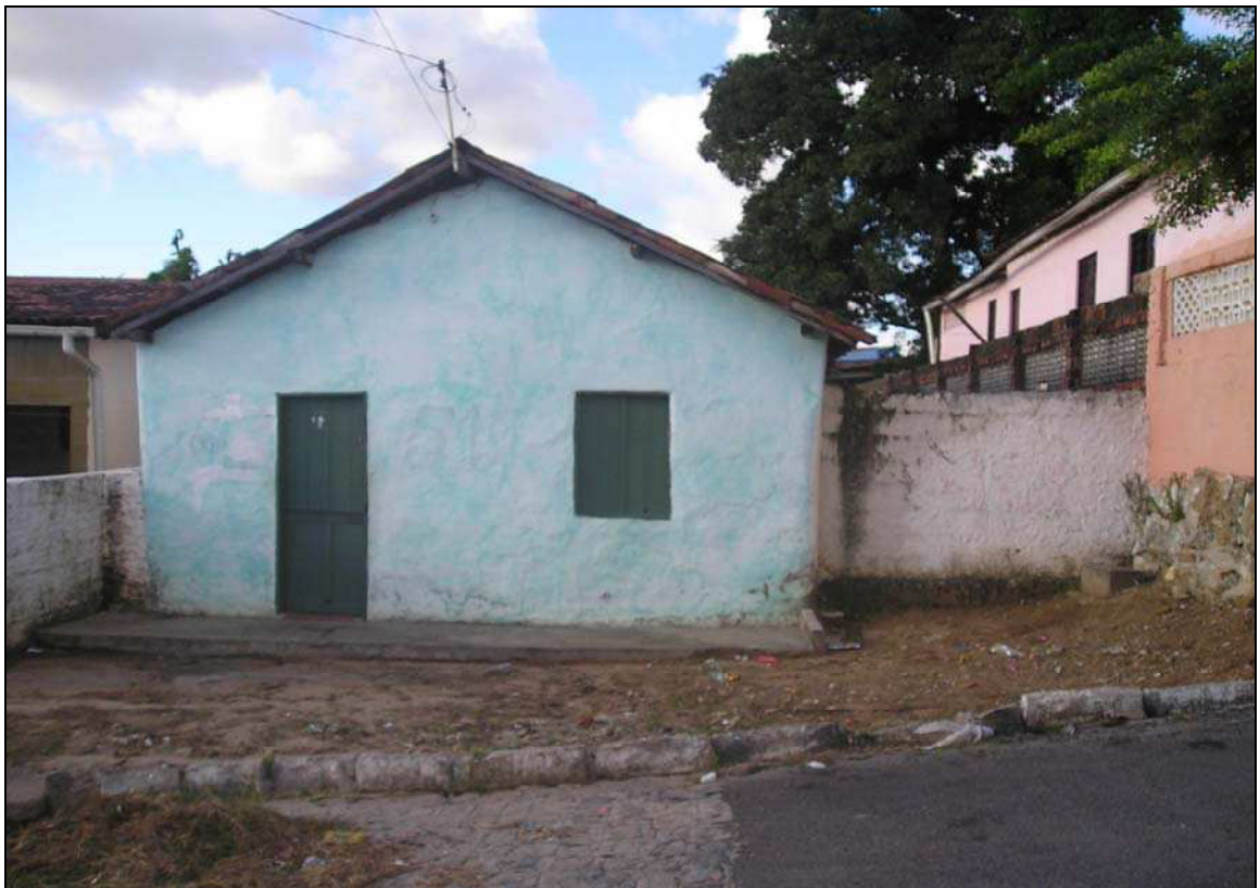
F.02 – Casa feita de taipa ainda presente o bairro, mesmo com a urbanização. Foto: Rafael Pontual (Maio/2006)
