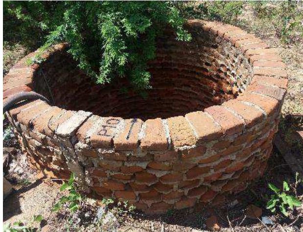
Figura 7: Poço em que é realizado o monitoramento do nível estático com marcação do local onde deve ser realizada a leitura do nível da água
