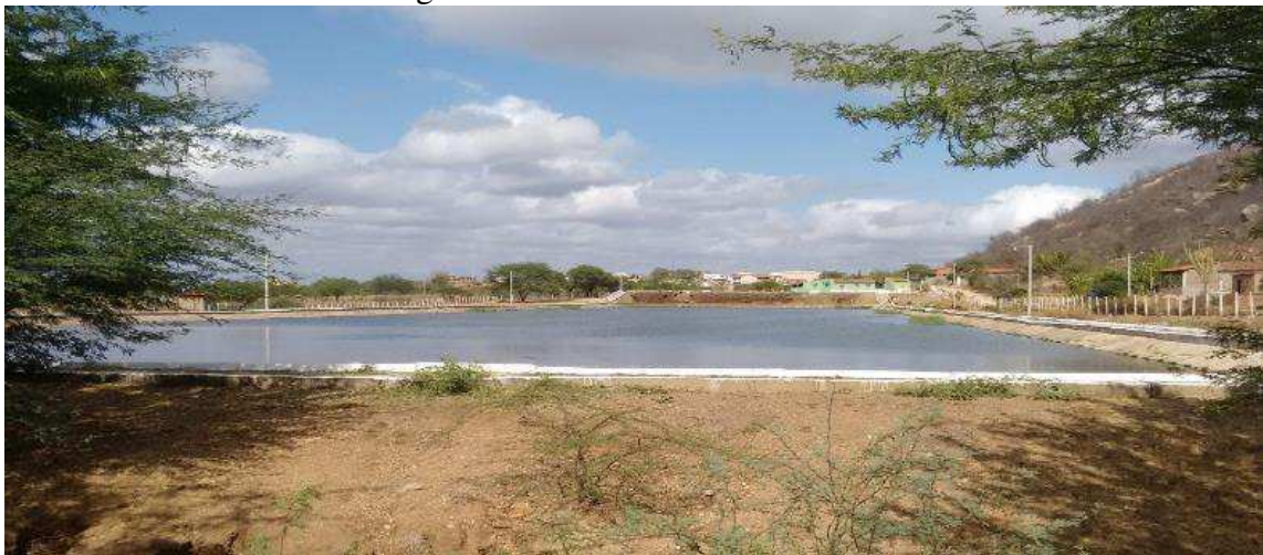
Figura 10: ETE da cidade de Sumé
