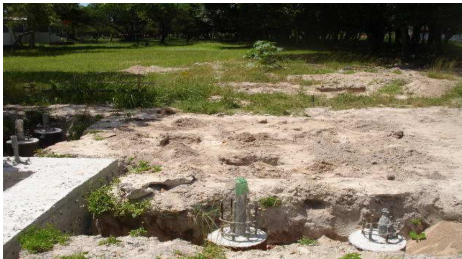
Figura 0.1 - Vista parcial do Campo I
