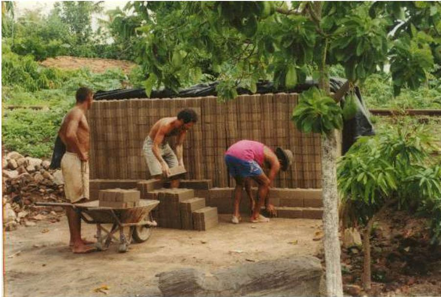
FIGURA 4.9 - Estocagem e cura dos tijolos
