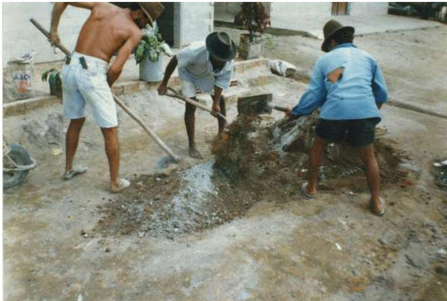
FIGURA 4.8 - Homogeneização da mistura terra-cimento-água.
