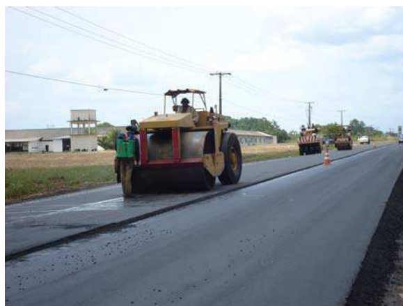
(d) Compactação da mistura asfáltica.
