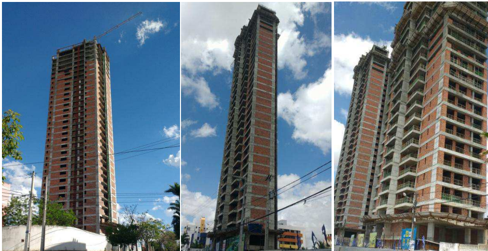
Figura 15: Edifícios em construção no Catolé. Fonte: A autora
