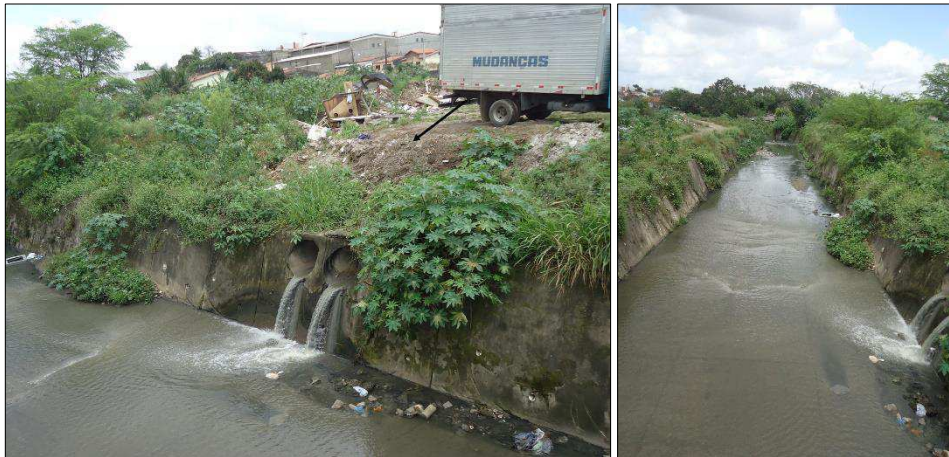
Figura 12 - Aterro lançado nas proximidades do canal e a vegetação invasora do seu leito
