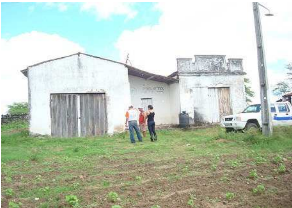
FIGURA 6. Mini-usina de descaroçamento de algodão no Assentamento Margarida Alves.
