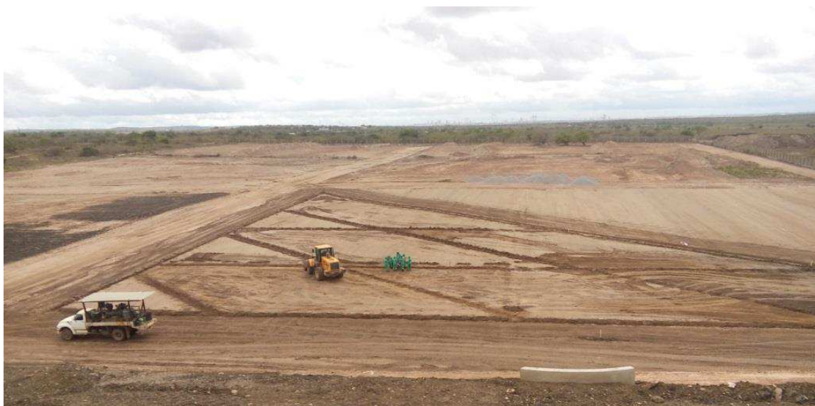
Figura 6 – Execução de camada de base do Aterro Sanitário de Campina Grande (PB)
