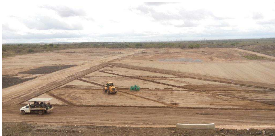
Figura 10 – Execução de camada de base do Aterro Sanitário de Campina Grande (PB)
