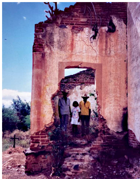
FOTOGRAFIA 09 – PORTAL, ENTRADA LATERAL DAS RUÍNAS DA IGREJA.
