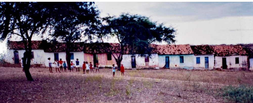
FOTOGRAFIA 03 – CASAS NO TRECHO IDENTIFICADO COMO SEDE E QUE FORAM CONSTRUÍDAS NO PERÍODO DA PRESENÇA DA CRC.
