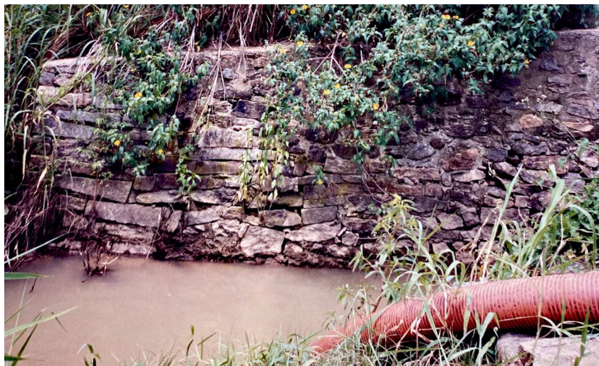
FOTOGRAFIA 05 – RESERVATÓRIO DE ÁGUA DA ÉPOCA DA CRC.
