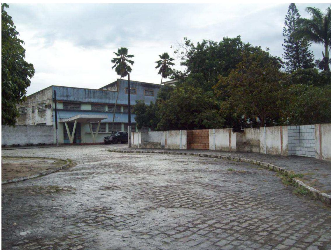
Fachada do Hospital Psiquiátrico João Ribeiro vista da entrada. Acervo pessoal. 2012
