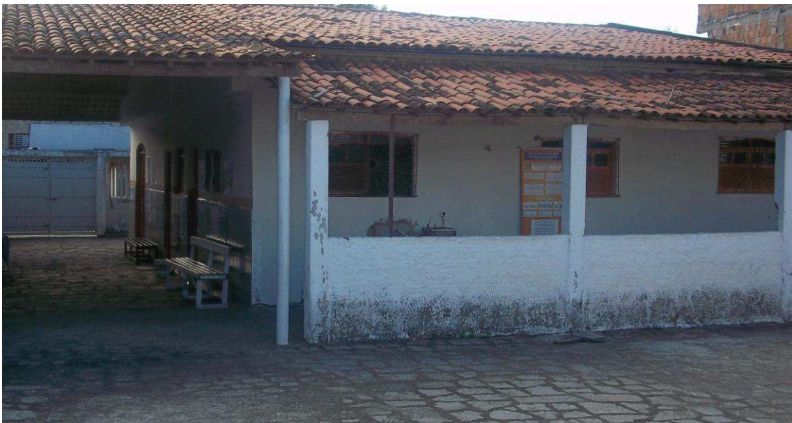
Parte interna da UBSF vista de dentro, no lado direito estão as salas dos profissionais da saúde, esquerdo sala de espera (corredor) com os bancos de cimento e madeira, espaço também de palestras. Acervo pessoal. 2011.
