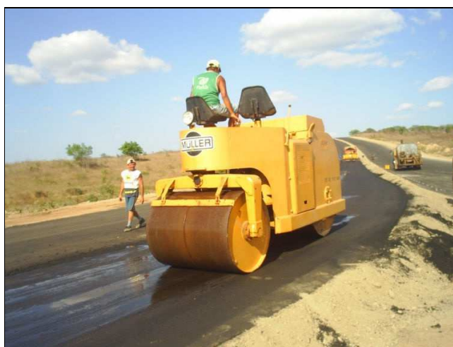
Figura 3.8 : Execução da conformação da base e imprimação, Av. Floriano Peixoto (2006)
