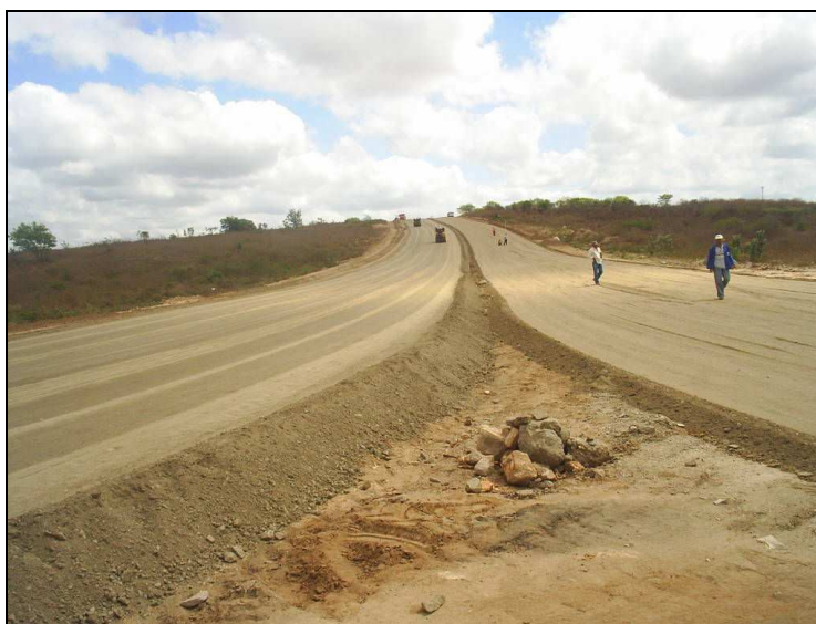
Figura 3.7 : Execução da Base, Av. Floriano Peixoto (2006)
