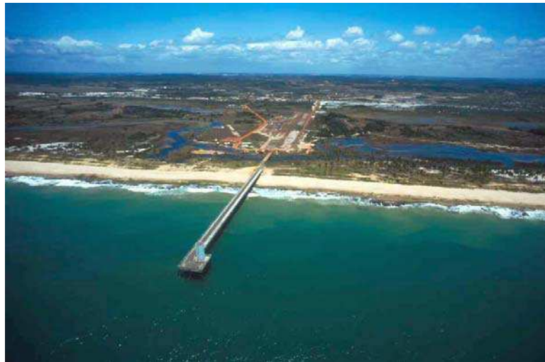
Figura 2.3 – Foto aérea do emissário submarino da Cetrel
