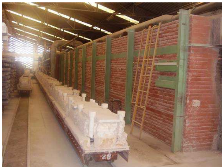
Figura 2.8 – Forno de alvenaria da Empresa Cotebras (Campina Grande-PB)
